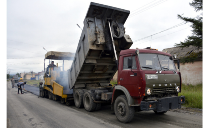
В рамках программы «Благоустройство муниципального образования «Ольский городской округ» на 2017 - 2019 г.г.» заасфальтирована улица Лесная.
