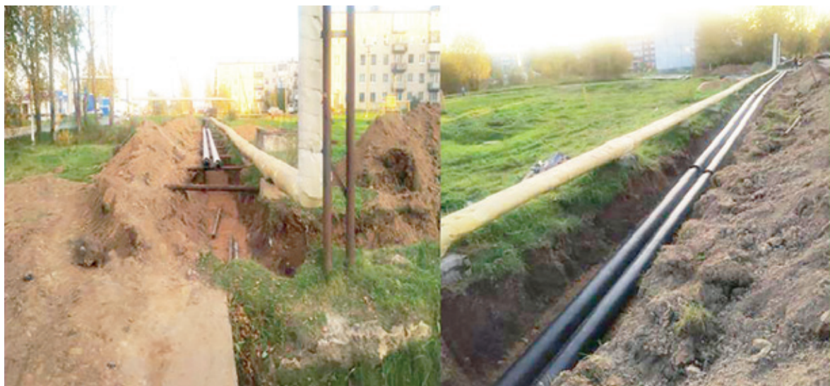
Ремонт участка теплотрассы в мкр-не Алексино
