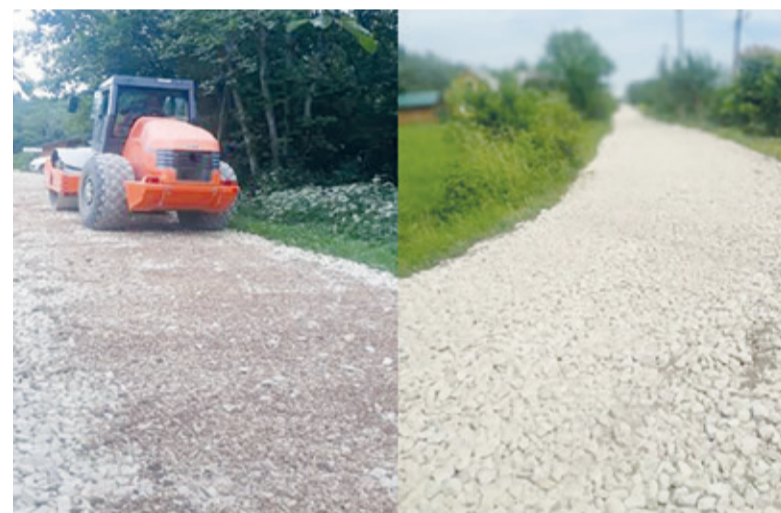
Ремонт дорог. Улица Клубная в Колчаново
