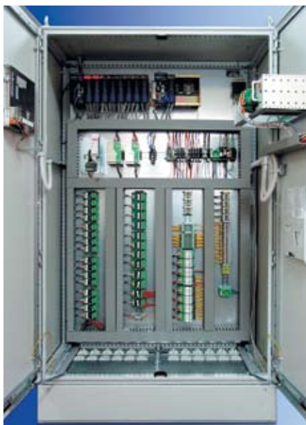
Контролируемый пункт телемеханики СТН-3000
