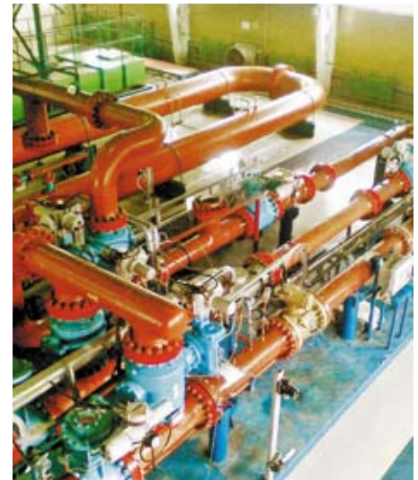
Система измерения количества и показателей качества конденсата
