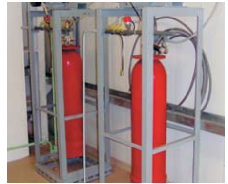
Установка газового пожаротушения
