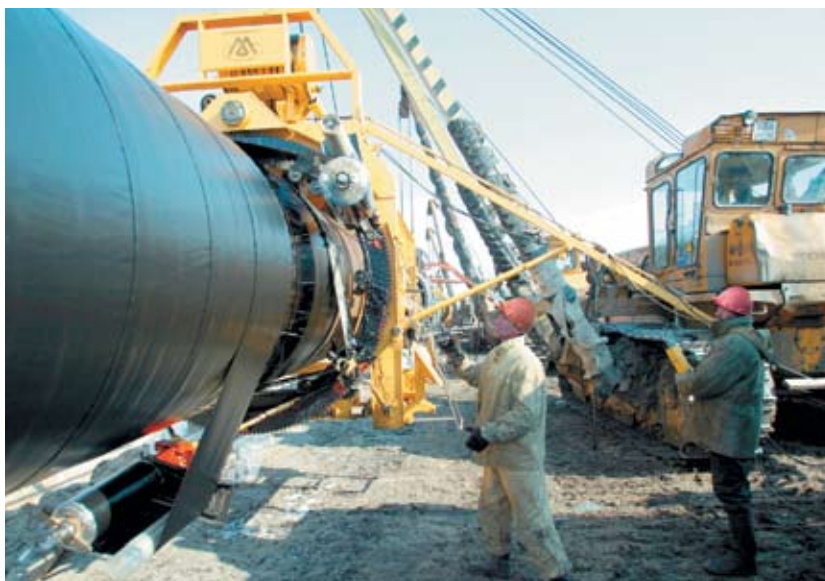
Переизоляция магистрального газопровода
