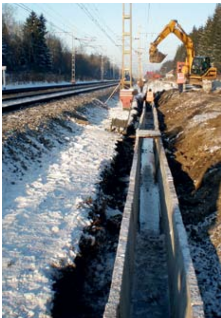
Водоотводные лотки вдоль главных путей направления Москва — Санкт-Петербург
