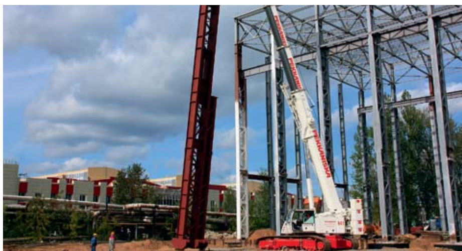
Строительство Тихвинского вагоностроительного завода
