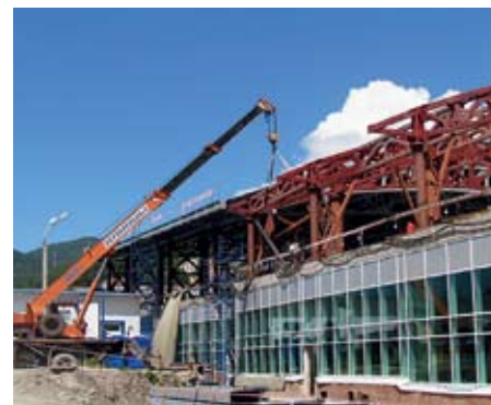
Строительство двухуровневого пассажирского вокзала на ст. Эсто-Садок
