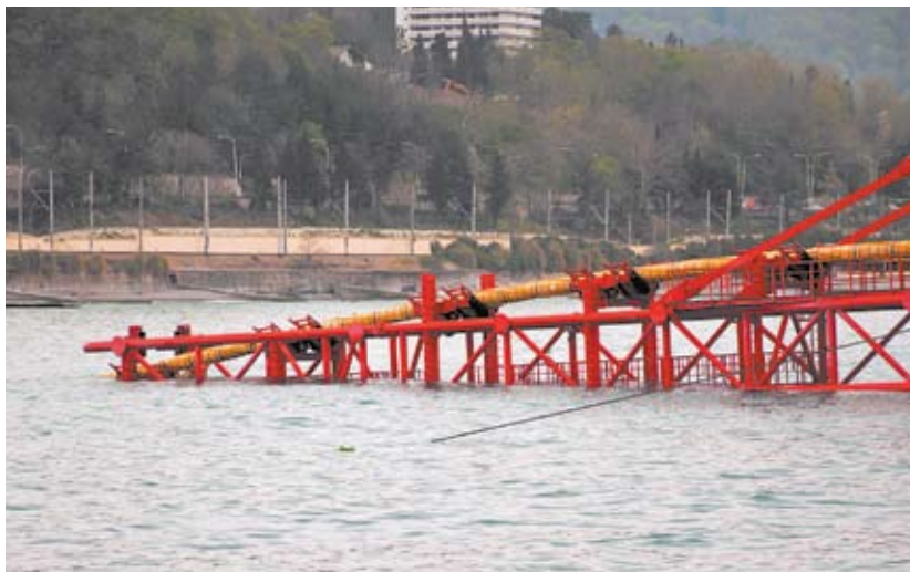
Соединение морской и сухопутной части газопровода в районе Кудепсты
