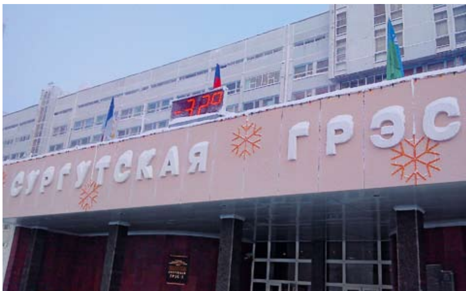
Здание управления Сургутской ГРЭС-2
