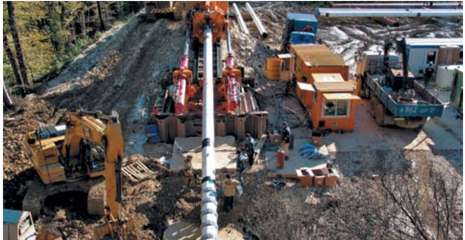
Доталкиватель, участок «Джубга»
