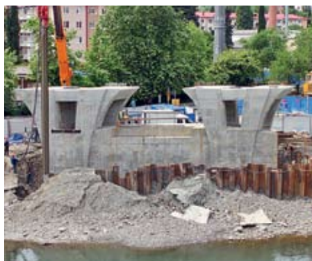
Мостовые опоры на берегу реки Сочи
