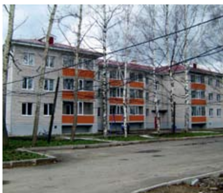
24-квартирный жилой дом в п. Сонково Тверской области
