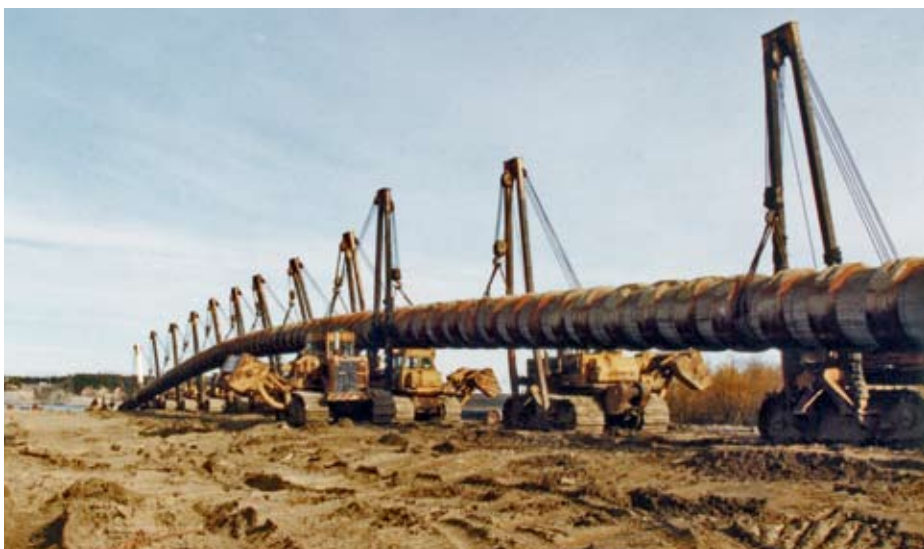
Укладка дюкера, Перегребненское ЛПУ
