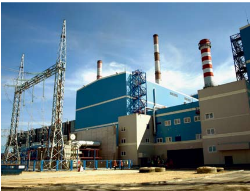
Два новых энергоблока ПГУ-400 Сургутской ГРЭС-2
