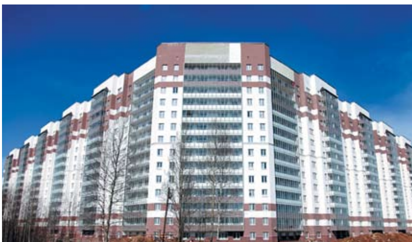
Жилой комплекс для сотрудников ТВСЗ в 1А-микрорайоне г. Тихвина
