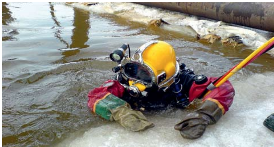
Обследование и капремонт системы подводных переходов
