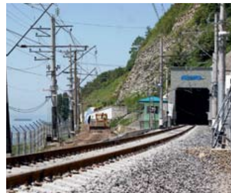
Тоннель Северо-Кавказской железной дороги
