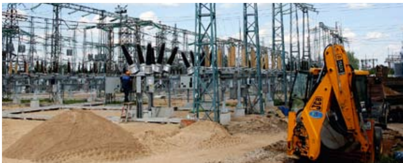
Реконструкция ПС «Псков»
