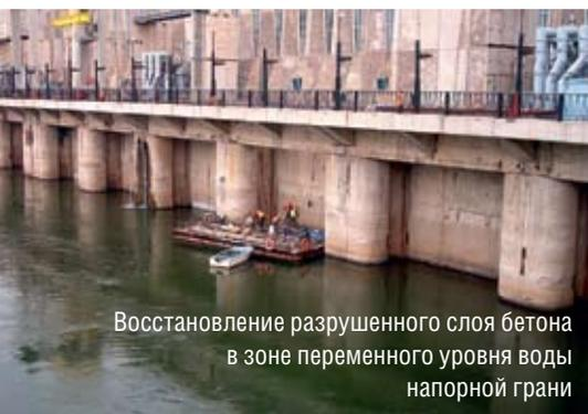
Восстановление разрушенного слоя бетона в зоне переменного уровня воды напорной грани
