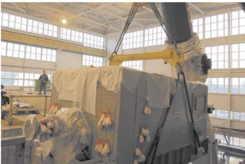
Установка генератора паровой турбины ПГУ 190 МВт на фундамент
