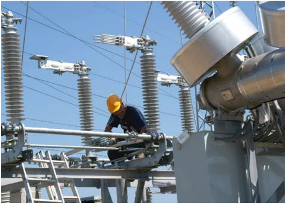
Реконструкция ПС №477 «Бруски»
