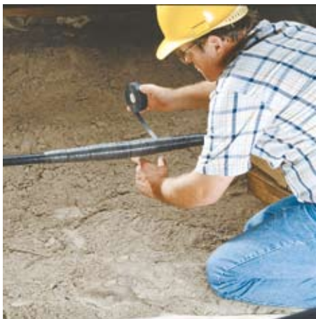
Монтаж муфты 3М
