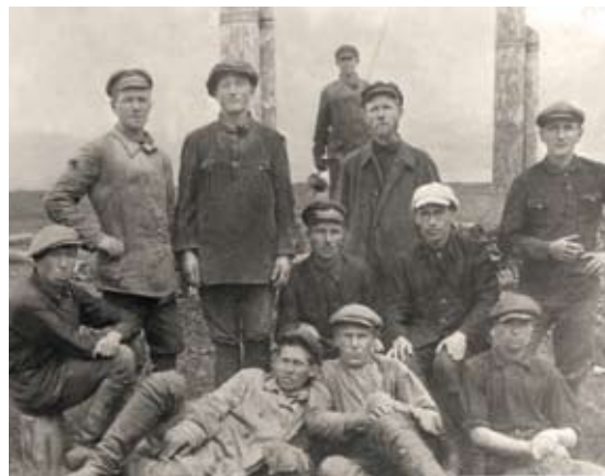
Бригада строителей ЛЭП 110 кВ Тула — Кашира
