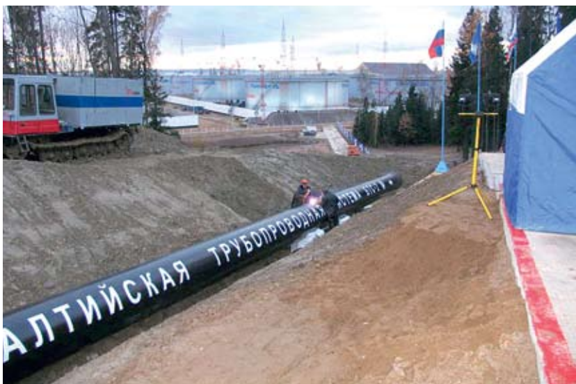
Сварка последнего стыка БТС-2
