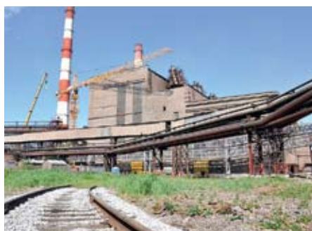
На ТЭЦ Череповецкого МК установлена деаэрационная установка
