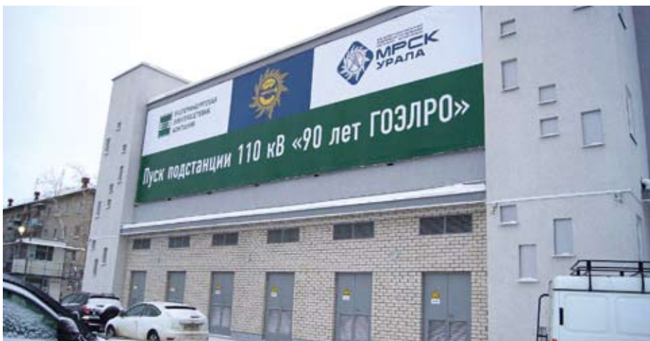
Подстанция закрытого типа 110 кВ «90 лет ГОЭЛРО»
