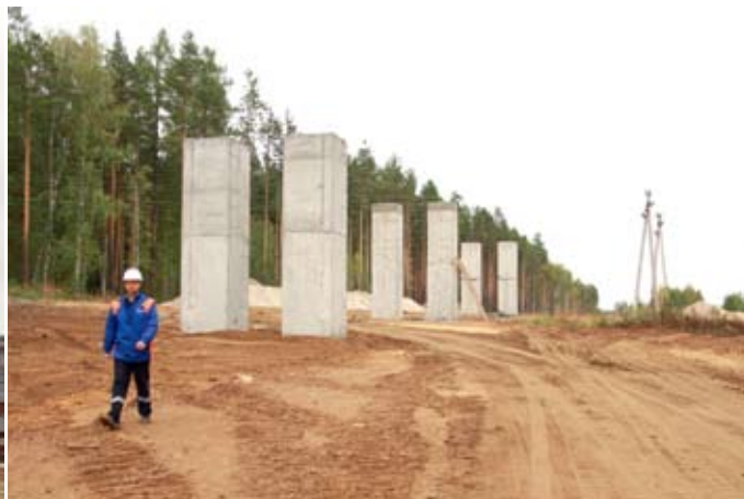
Фундаменты трассы трубо-ленточного конвейера
