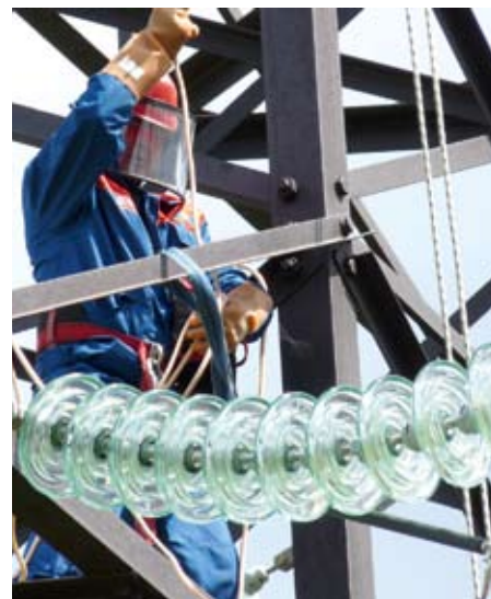
Работы на ВЛ
