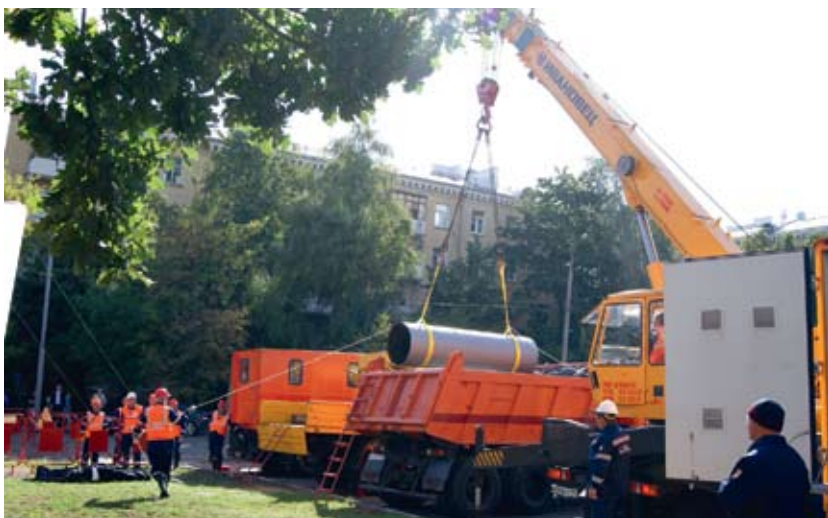
Ремонт магистральной тепловой сети (г. Москва)
