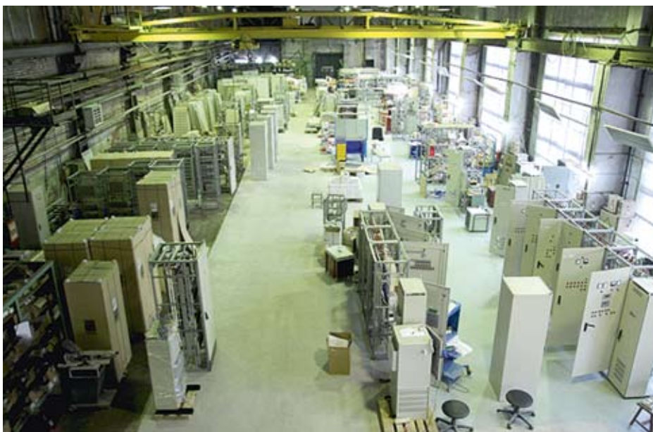
Цех сборки щитов постоянного тока
