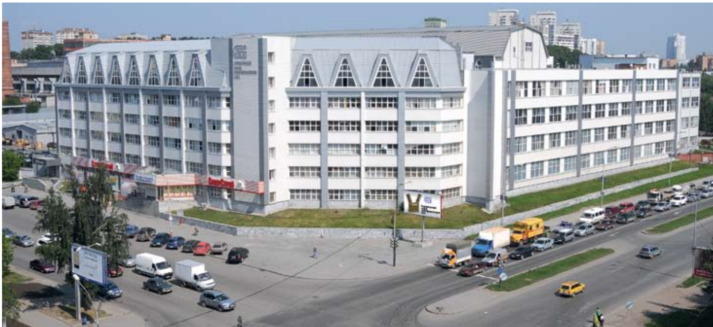
Здание ОАО «Свердловский завод трансформаторов тока»
