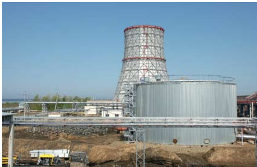
Юго-Западная ТЭЦ. Забивка свай под баки ГВС второй очереди. 2011 год
