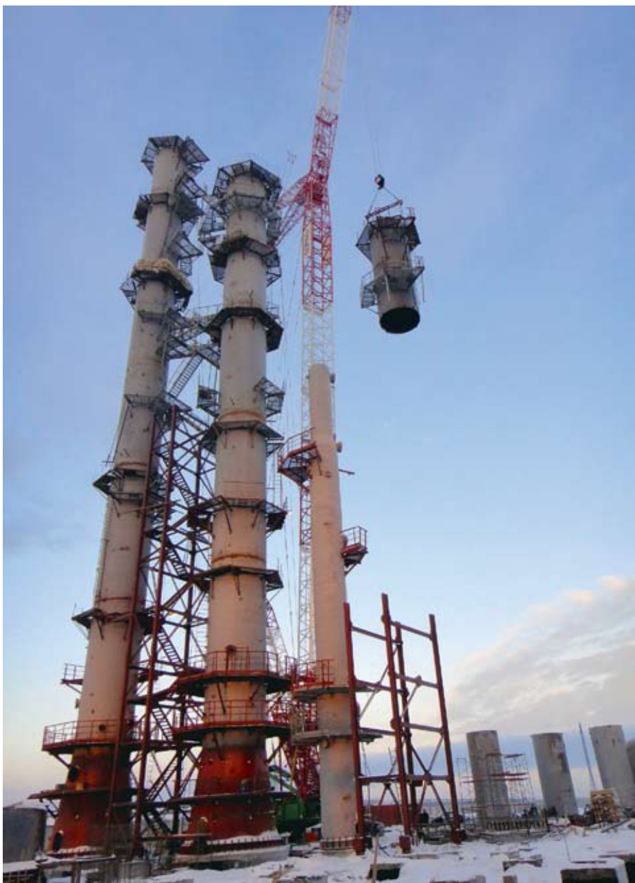
Монтаж колонн установки по переработке пропан-пропиленовой фракции, г. Омск
