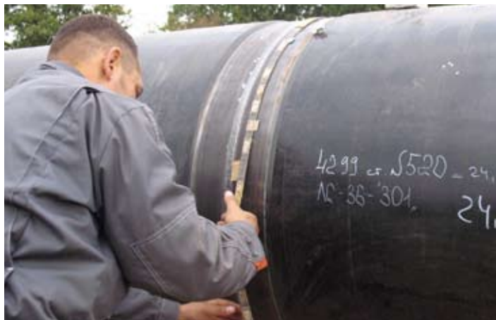
Подготовка сварных стыков к рентгенографическому контролю
