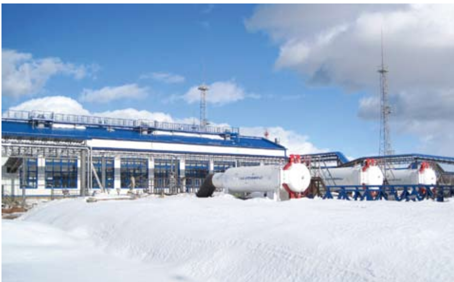
НПС-7. Балтийская трубопроводная система-2
