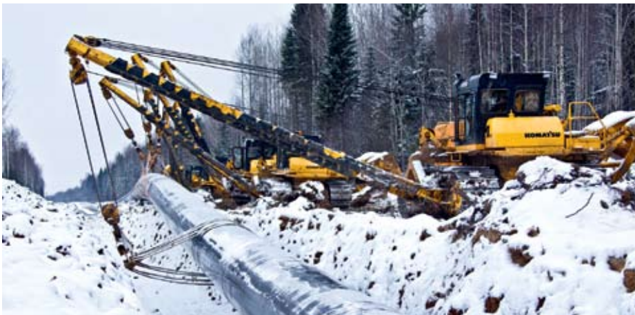
Укладка трубопровода в траншею на объекте «Система магистральных газопроводов «Ухта — Торжок»
