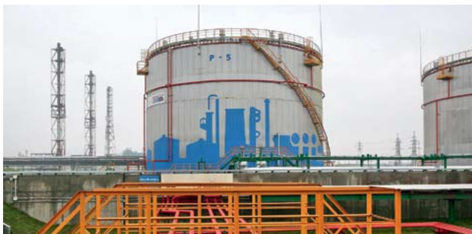
Комплекс сооружений и резервуаров сырой нефти. ОАО «Славнефть-ЯНОС»
