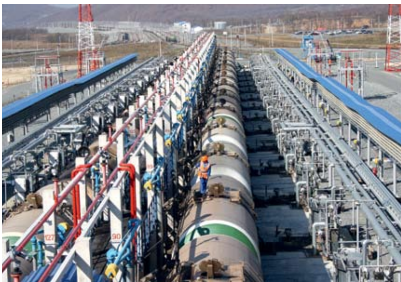
Площадка железнодорожных эстакад СМНП Козьмино
