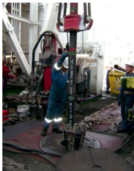
Спуск трубной колонны с трубами ТМК в скважину глубиной более 2,5 километра на месторождении им. Юрия Корчагина
