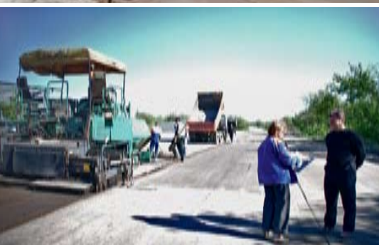
Строительство дороги из грунтобетонной смеси, имеющей в своем составе буровые шламы
