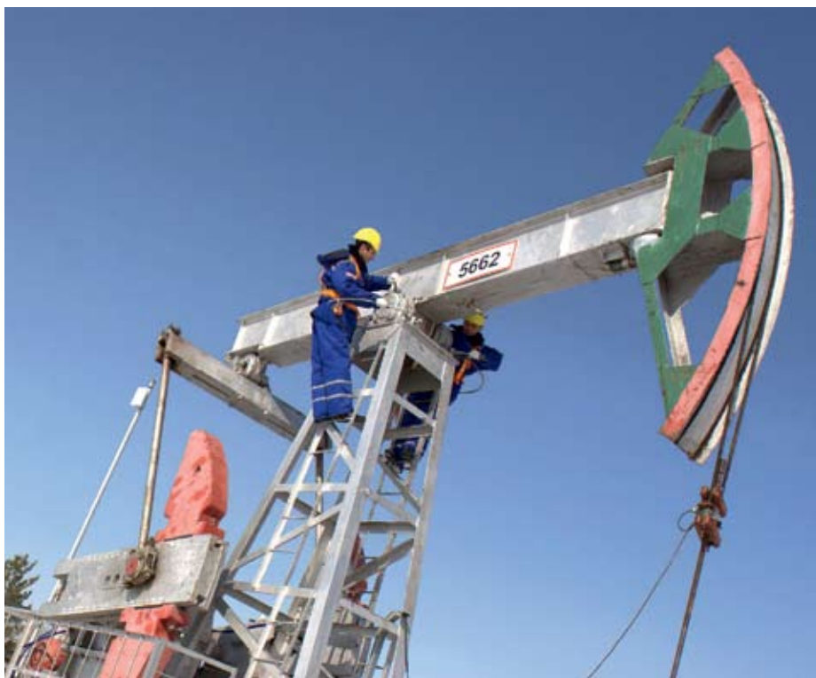
Техобслуживание приводов ШГН, ООО «МехСервис-НПО»
