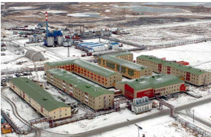
Вахтово-жилищный комплекс на Бованенковском месторождении
