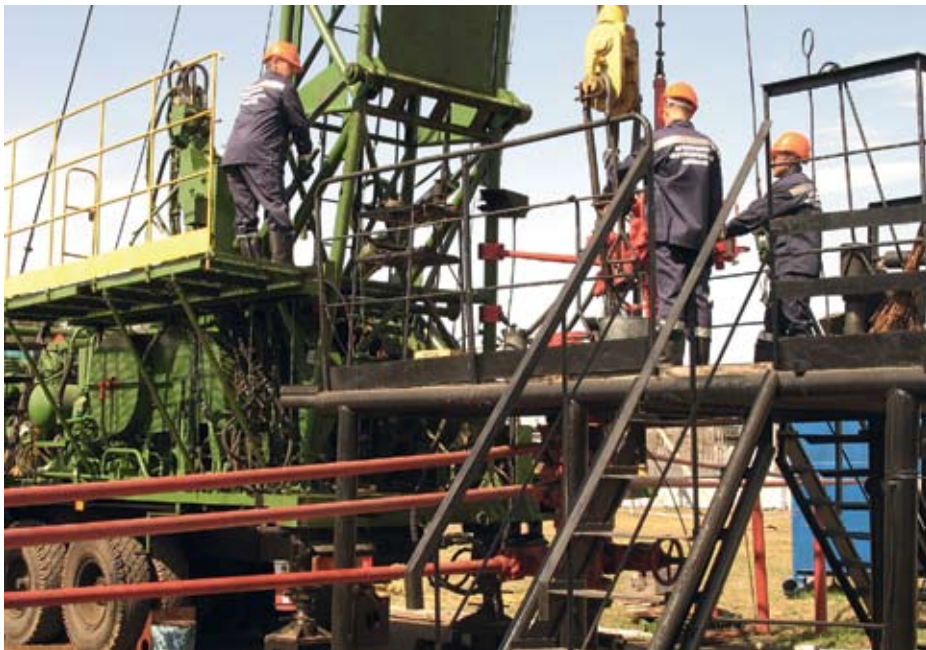
Капитальный ремонт скважин на объекте ОАО «Оренбургнефть»
