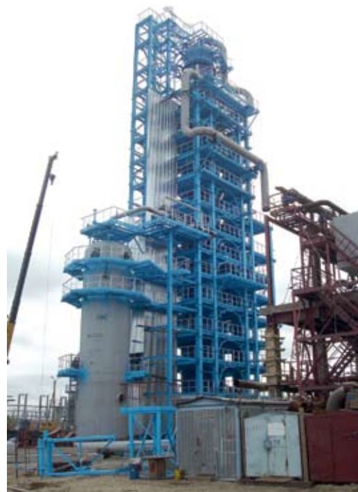
Колонна К-1 — сердце будущего предприятия
