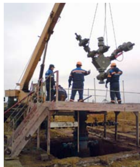
Монтаж елки фонтанной из титановых сплавов на скважине ОАО «Газпром добыча Астрахань»
