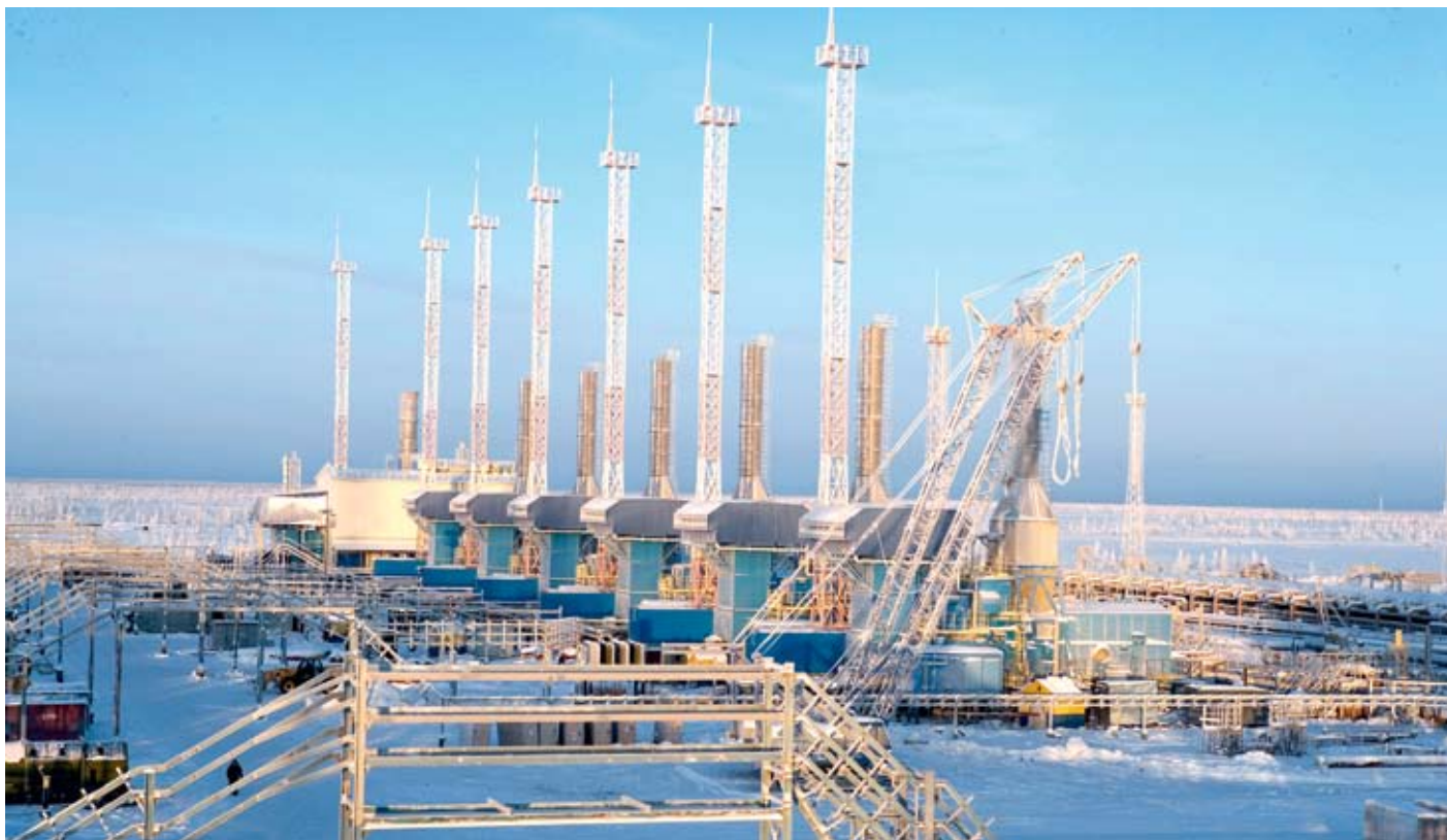
Заполярная промплощадка Ново-Уренгойского ЛПУ МГ
