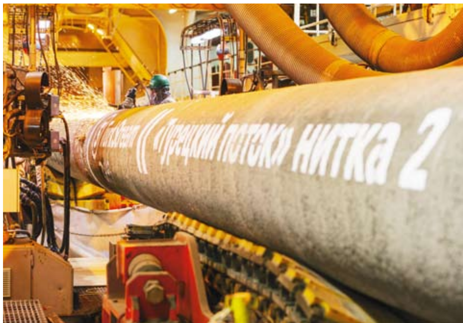
Сварка замыкающего стыка на морском участке газопровода «Турецкий поток»
