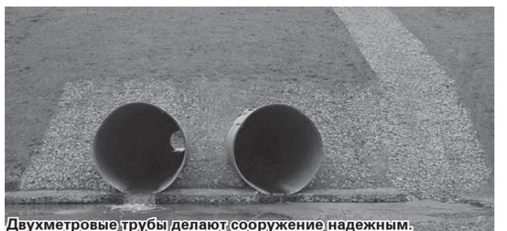
Двухметровые трубы делают сооружение надежным.
