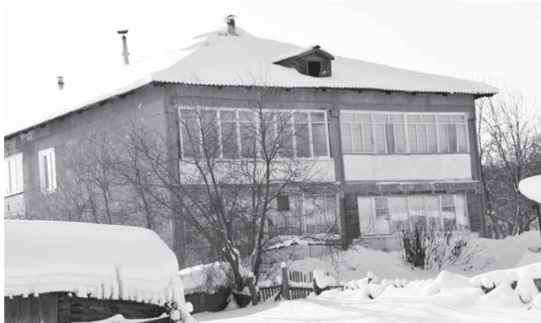
Жильцы этого дома уже предотвратили обрушение кровли.
