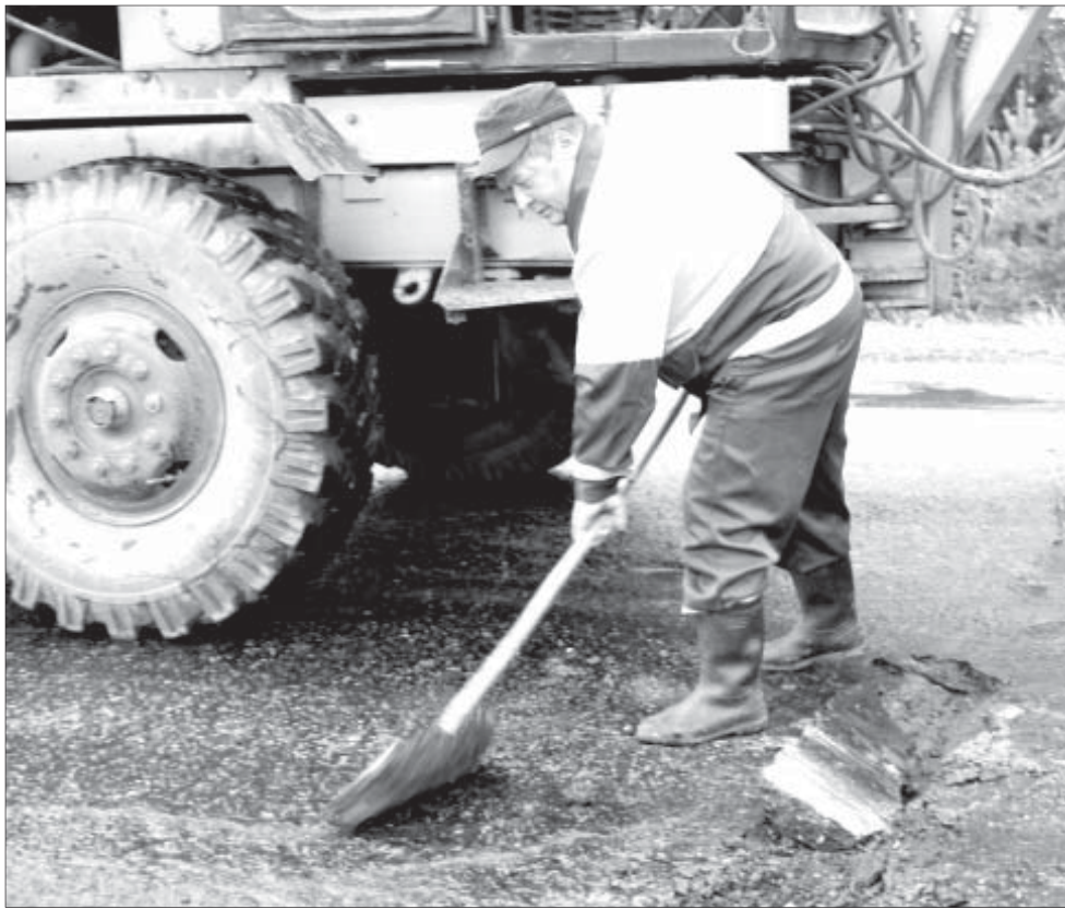
Механизатор ДУ Александр Пушкарёв проводит ямочный ремонт.
