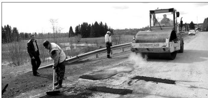
■ Рабочие Юкаменского ремонтно-строительного участка «чинят» дороги.
