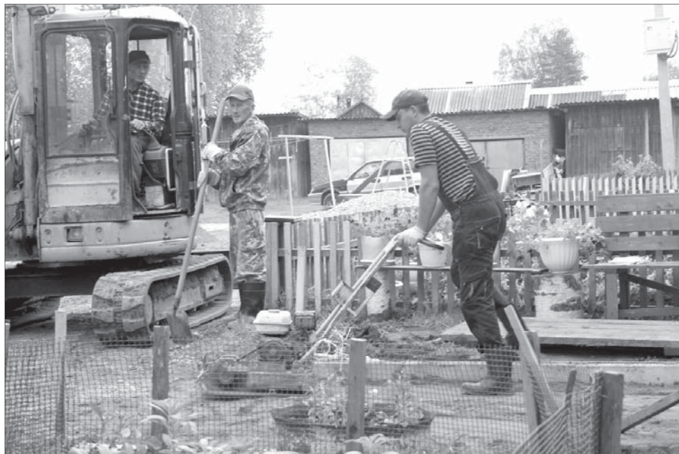
Идут работы по благоустройству территории дома №35 по ул. Вежевская.
