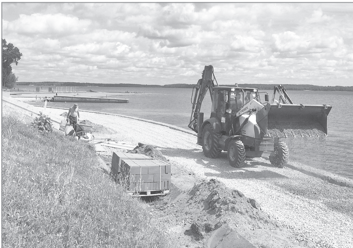
Работы по благоустройству набережной у Обелиска
