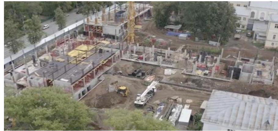
Строительство учебного корпуса , Пермский авиационный техникум им. А.Д. Швецова
