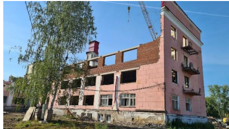
Реставрация Пермского политехнического колледжа им. Славянова
