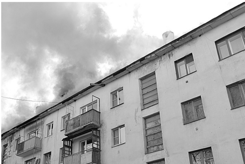
На ремонт поврежденной пожаром системы отопления дома из городского бюджета уже затрачено около 500 тыс. рублей. Всего на восстановление крыши требуется более 4 млн. рублей
