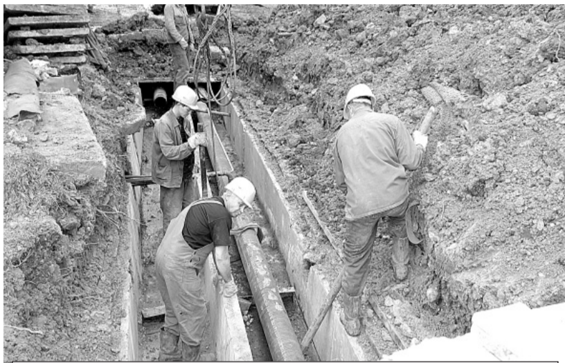
После окончания работ на малом кольце тепловая система города Железногорска-Илимского будет работать в полную силу
