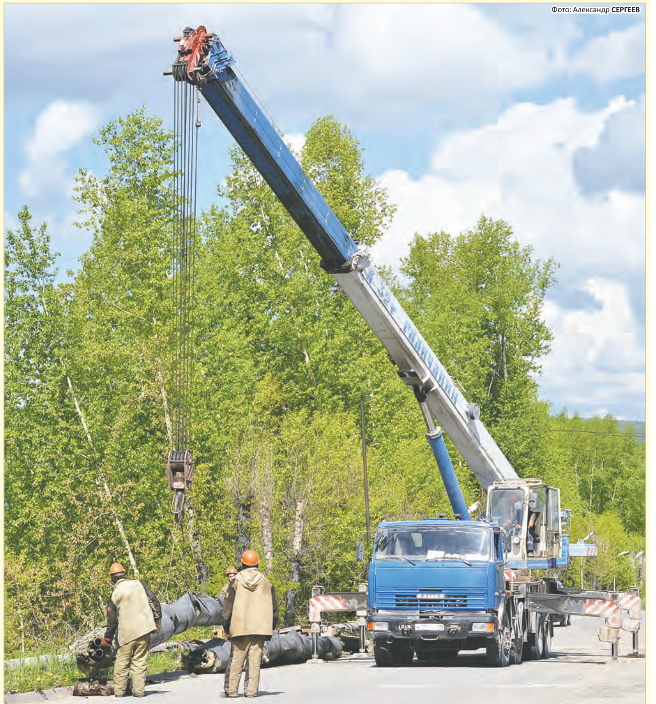
Восстановительные работы на мазутопроводе ведет бригада участка спецработ СМУ под руководством бригадира Алексея Пиотровского
