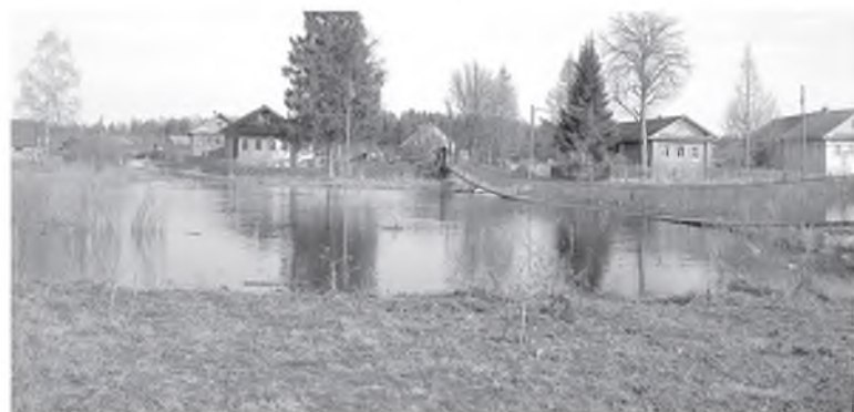
Половодье 2012 года, мост через р. Шуя. | фото Павла Смирнова.
