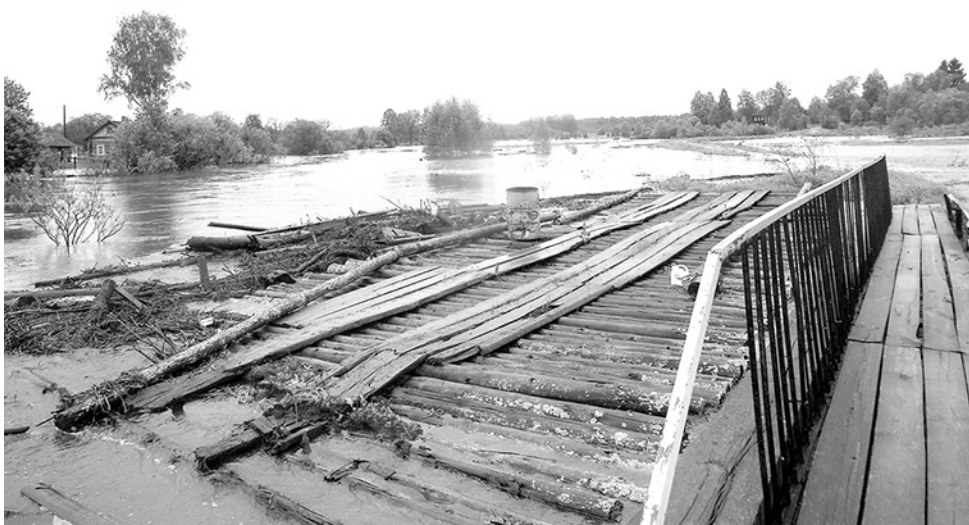
Мост через Шингарь. | Фото Владимира Нужина.
