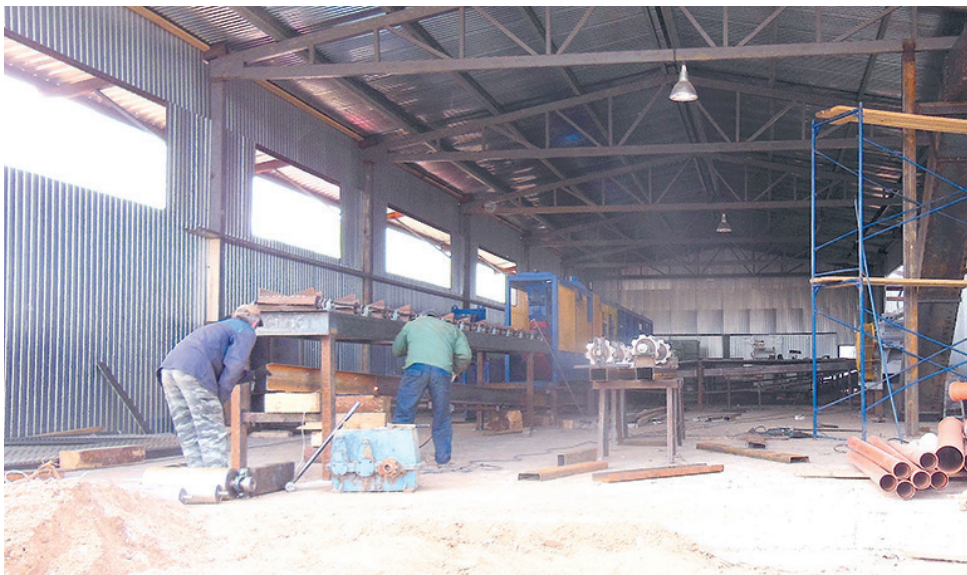
Монтаж оборудования для нового цеха. | фото Владимира Нужина.
