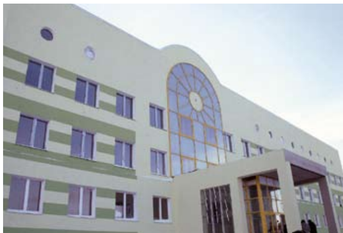
Строящийся родильный дом с перинатальным центром в городе Октябрьском
