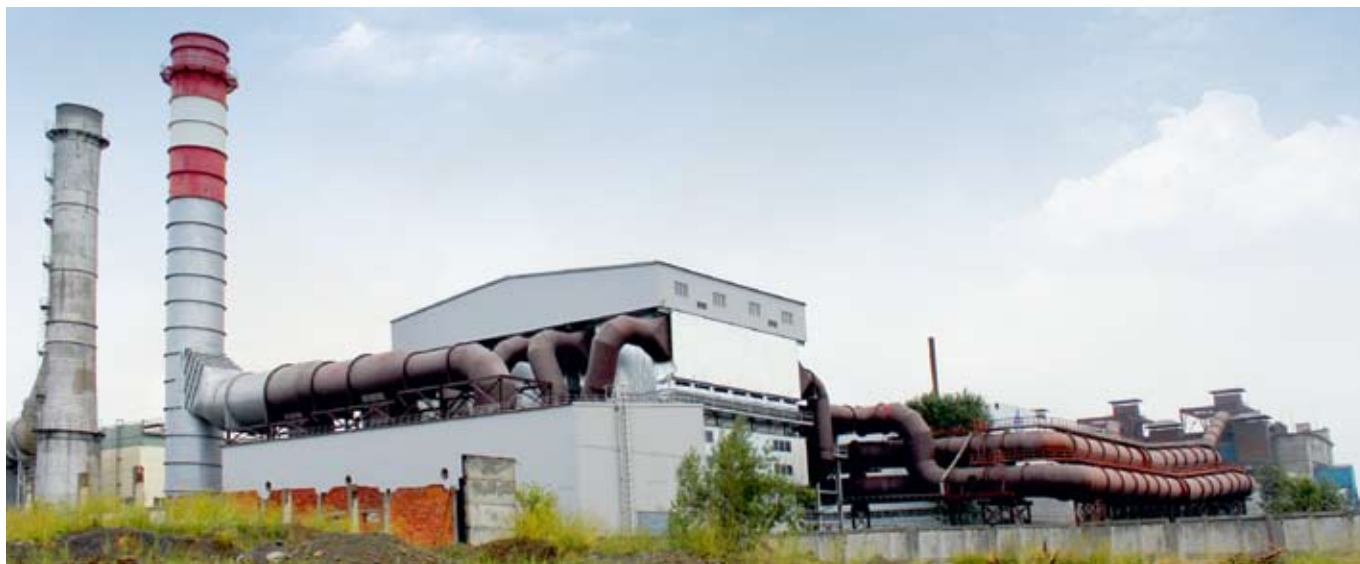
Газоочистные сооружения за печами № 7, 8, 9 цеха № 1
