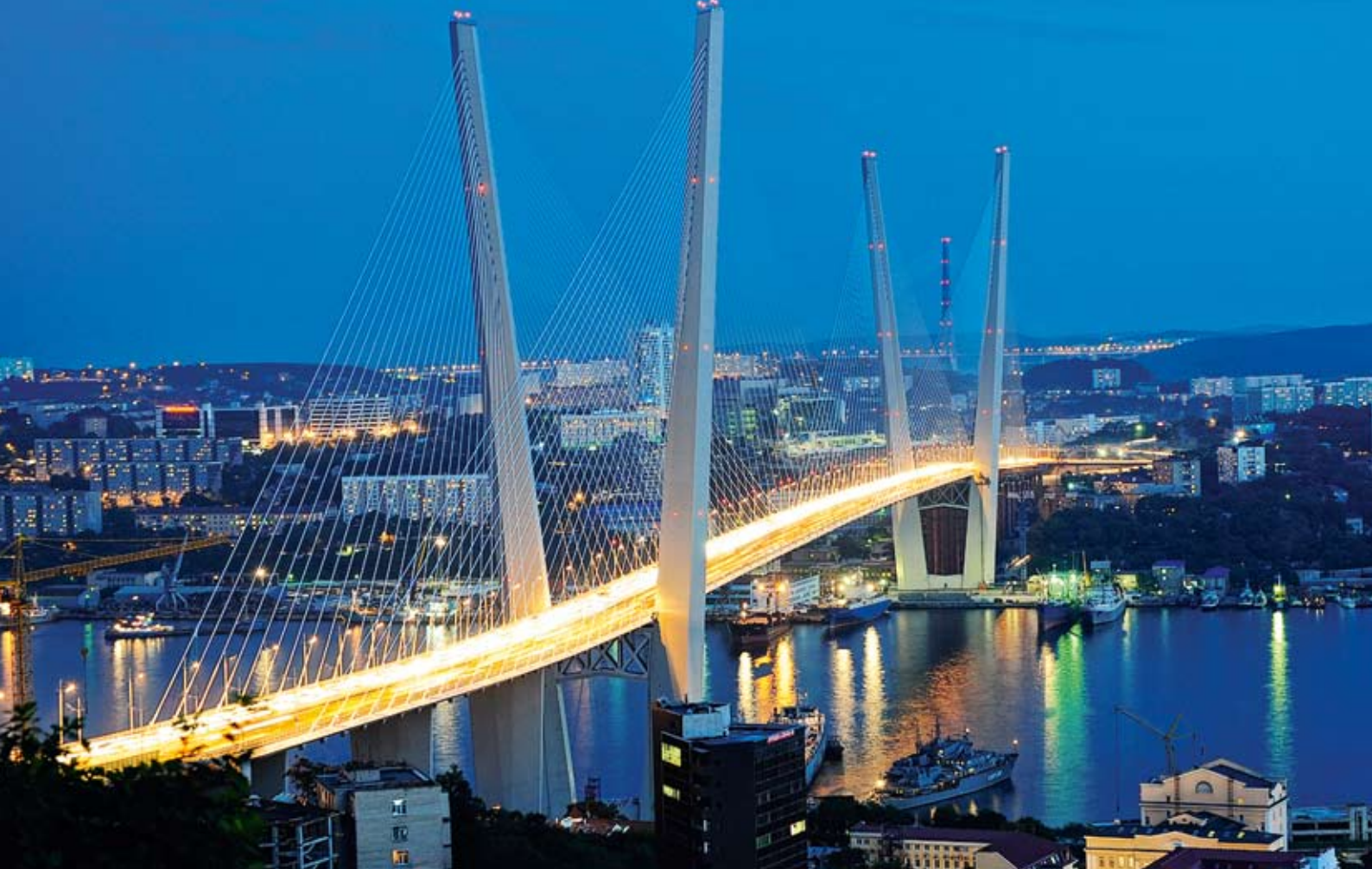
Мост на остров Русский через бухту Золотой Рог во Владивостоке
