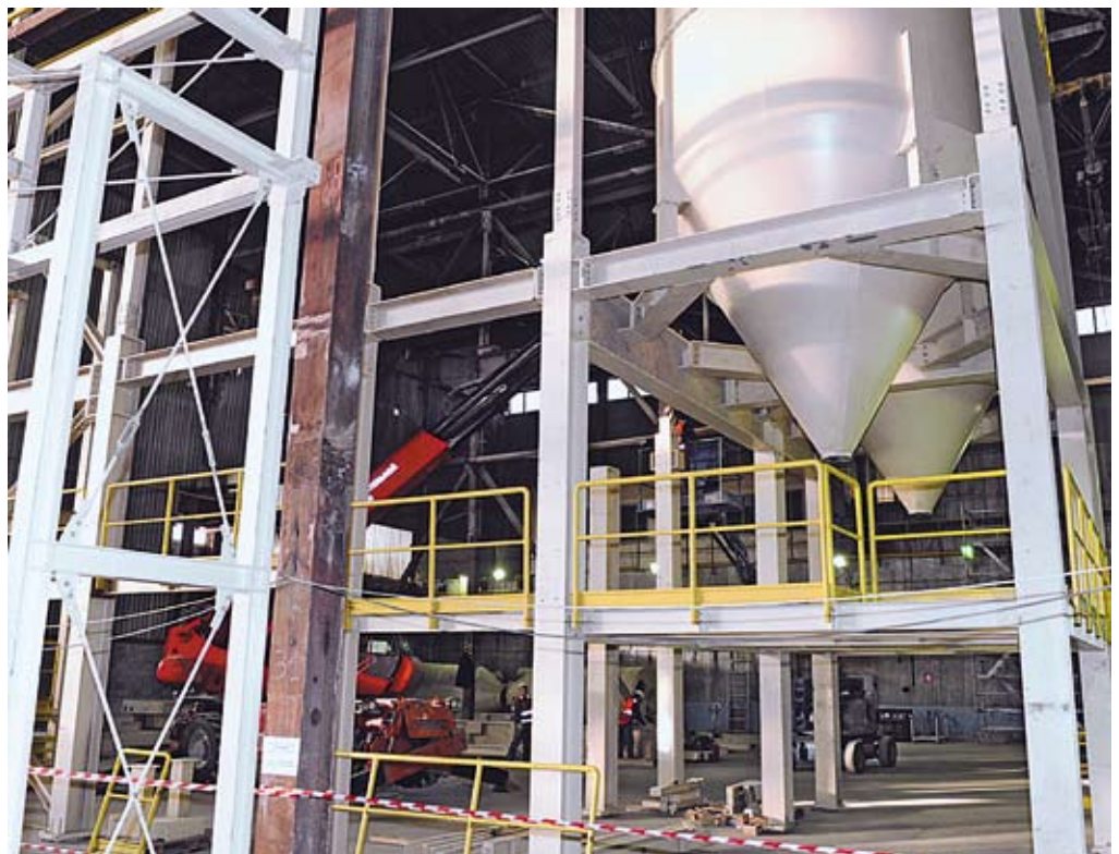
Строительство завода теплоизоляционных материалов «КнауфИнсулейшен». Сумма инвестиций — 2,5 миллиарда рублей
