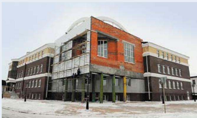
Завершается строительство нового корпуса Ишимского государственного педагогического института имени П.П. Ершова
