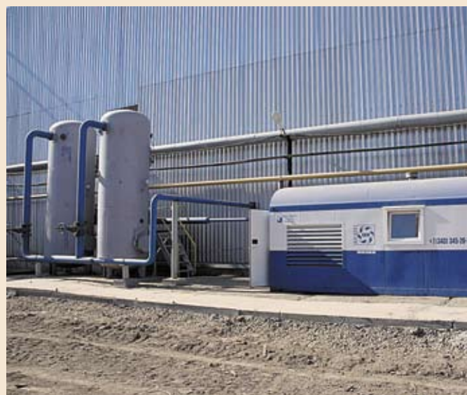
Компрессорная участка помола цеха № 1
