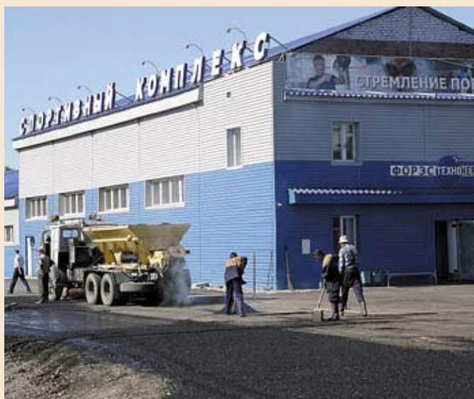
Новый спорткомплекс. Благоустройство прилегающей территории
