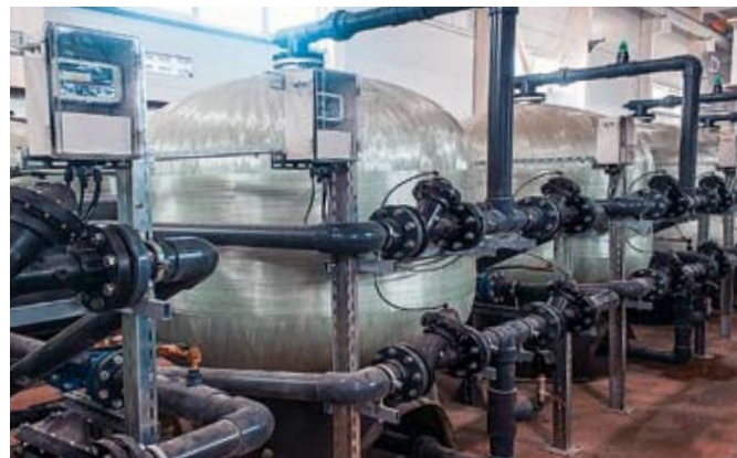
Установка очистки воды
