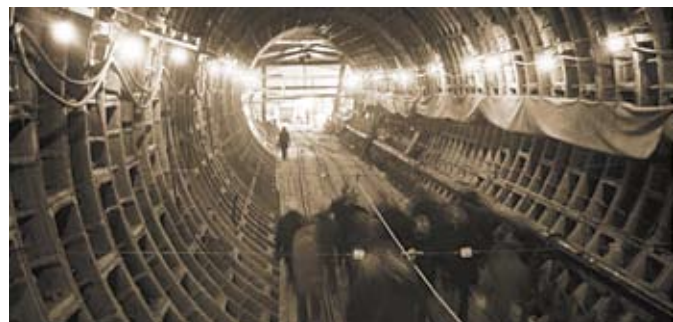
Северо-Муйский тоннель строился намного дольше любого другого объекта БАМа — он был сдан в эксплуатацию только в 2003 году, с опозданием на 16 лет. Сегодня это самый крупный железнодорожный тоннель в России
