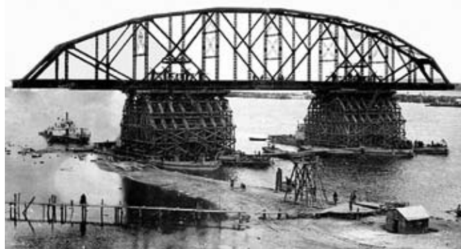
Строительство Амурского моста
