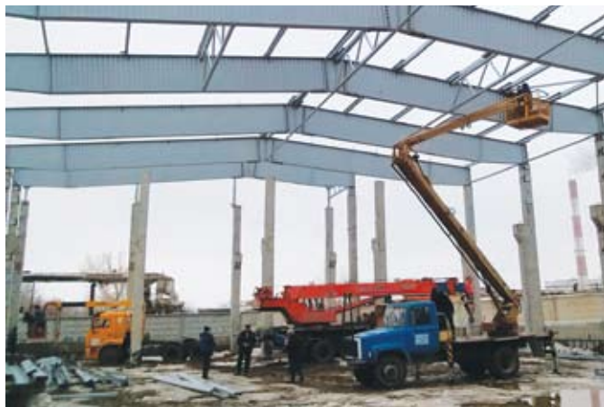
Монтаж конструкции, разработанной ООО «ОренЗМК»
