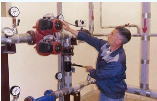
У индивидуального теплового пункта многоквартирного дома с установленным узлом учета и регулирования тепловой энергии
