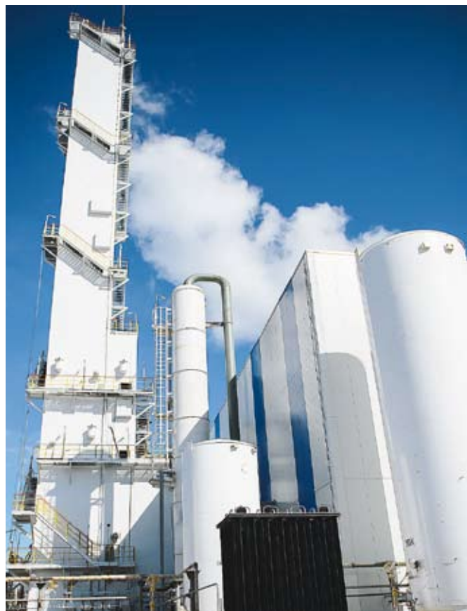
Новая воздухоразделительная установка
