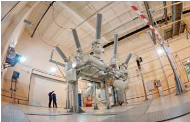
На подстанции «Приречная» (Нижний Тагил)
