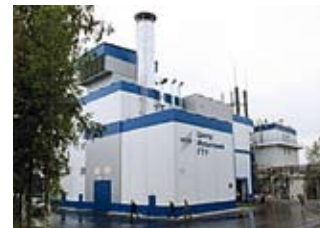
Испытательная установка ГТУ «Протон»
