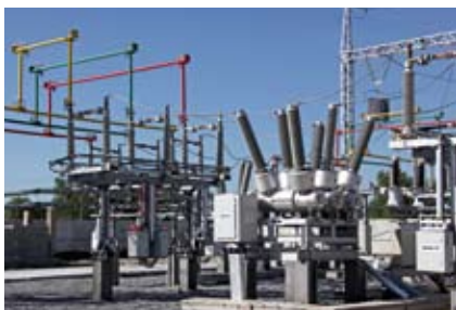
Подстанция «Авиатор» (Екатеринбург)
