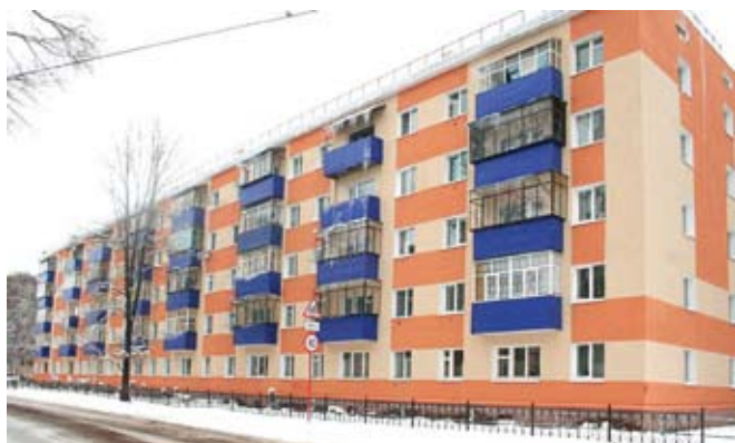
Жилой дом в Стерлитамаке (улица Революционная, 8) после капитального ремонта
