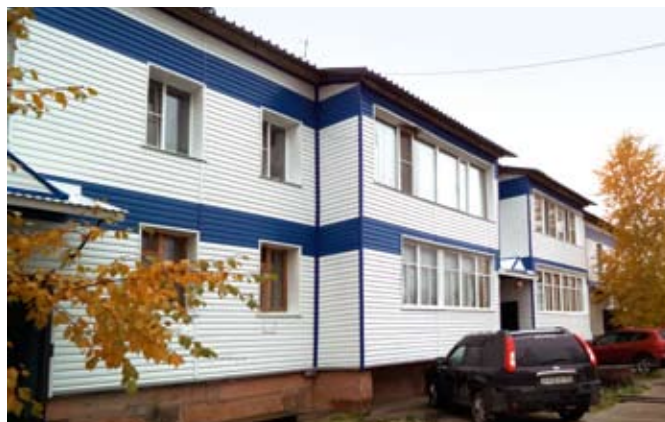
Жилой дом в Нягани (улица Пионерская, 147) после капитального ремонта
