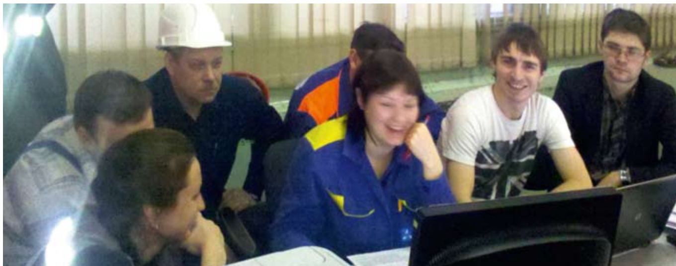
Автоматический запуск котла на Первоуральской ТЭЦ при помощи системы управления, созданной на базе аппаратуры «Omron»
