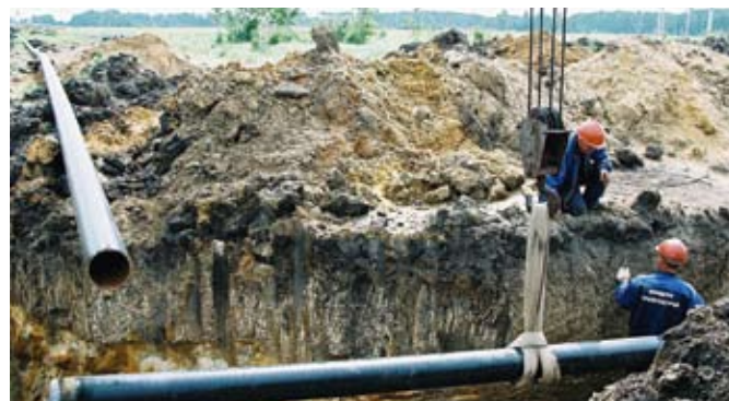
Закладка газопроводных труб
