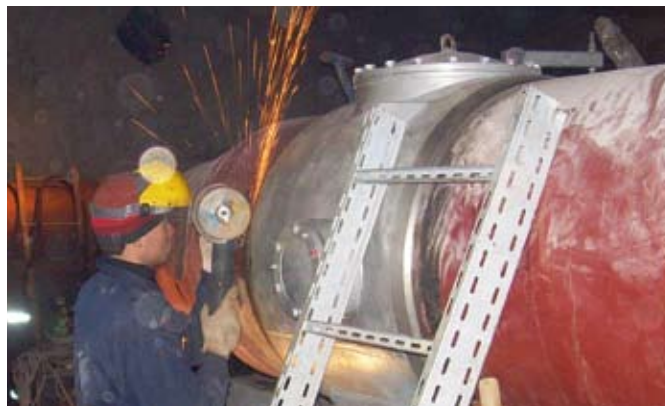
Зачистка сварных швов трубопровода технической воды в машинном зале четвертого блока БАЭС
