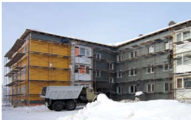
Строительство жилого дома в Когалыме
