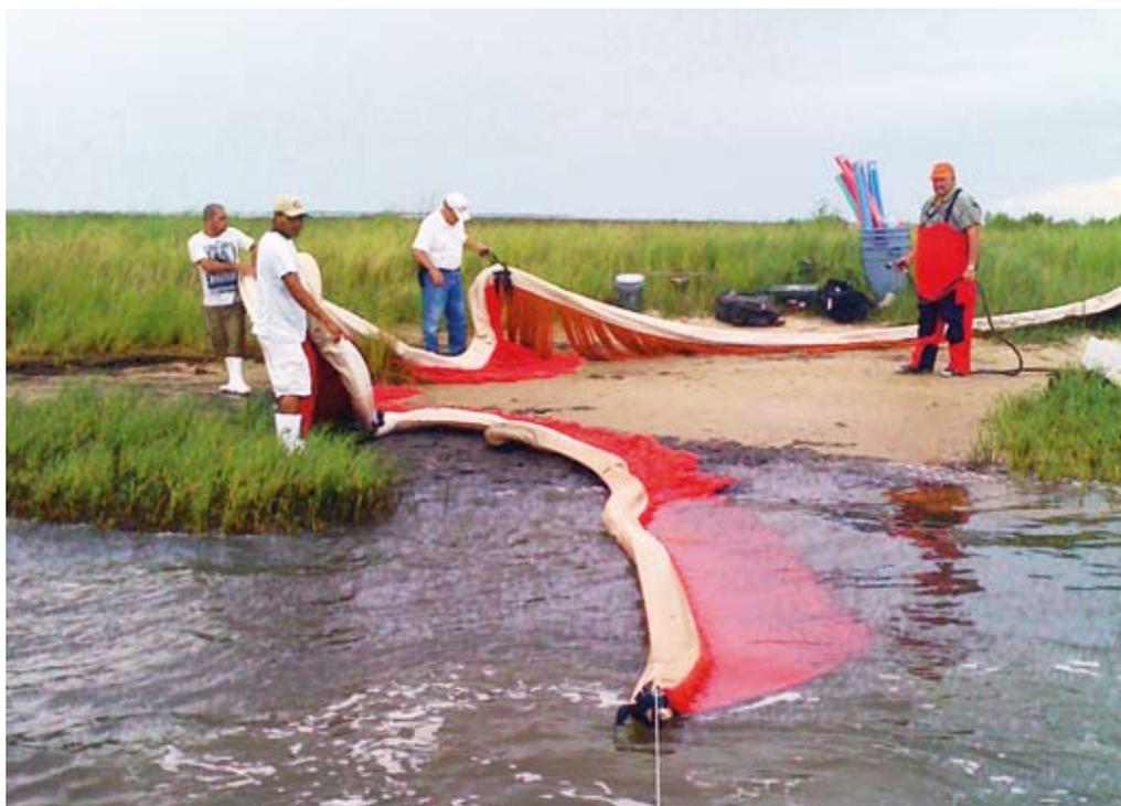
Нефтесорбирующий бон (биофильтр) позволяет снизить концентрацию пленочных нефтепродуктов в 40—50 раз, растворенных — в 5—15 раз
