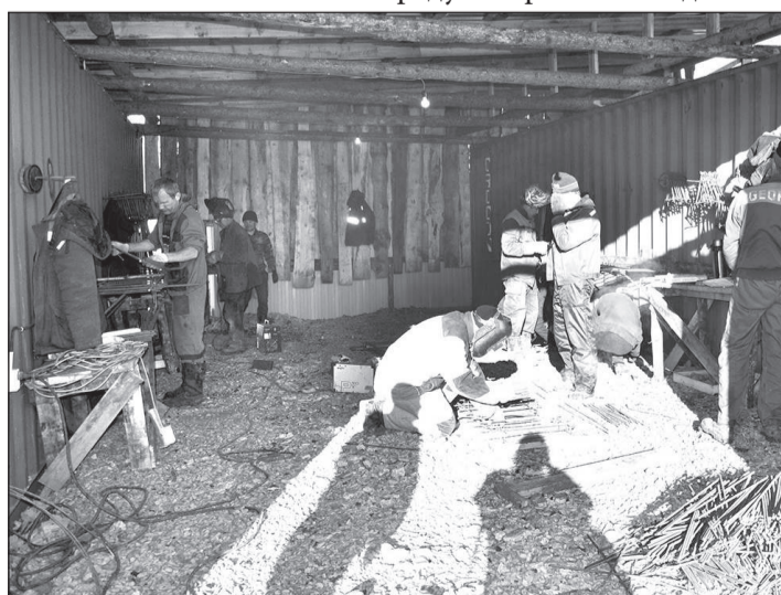
Идет погружение свай
