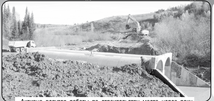
Активно ведутся работы по строительству моста через реку Полдневую. Скоро проезд здесь будет удобным и безопасным.
