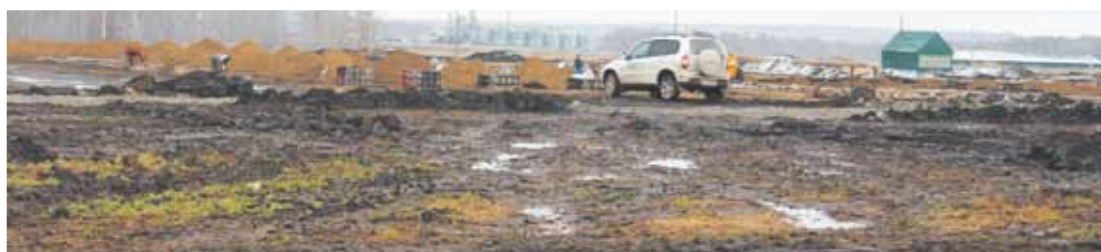
Рядом с Пеньковским животноводческим комплексом развернулось масштабное строительство
