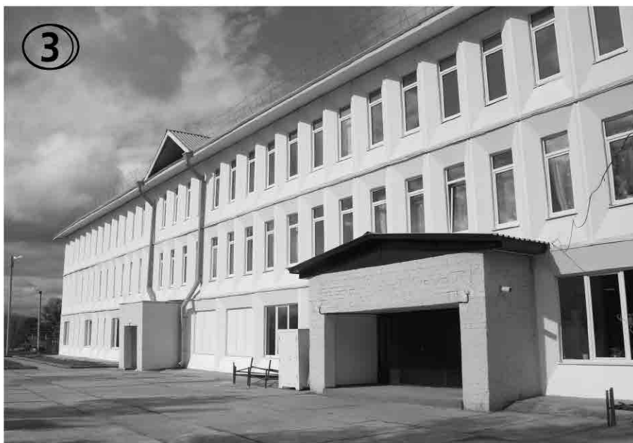
На снимке: В здании Качугской школы №1 завершился ремонт и возобновился учебный процесс
