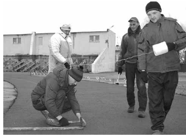
На новую беговую дорожку стадиона «Нива» нанесена разметка для покраски, которая будет осуществлена в начале будущего летнего спортивного сезона.
