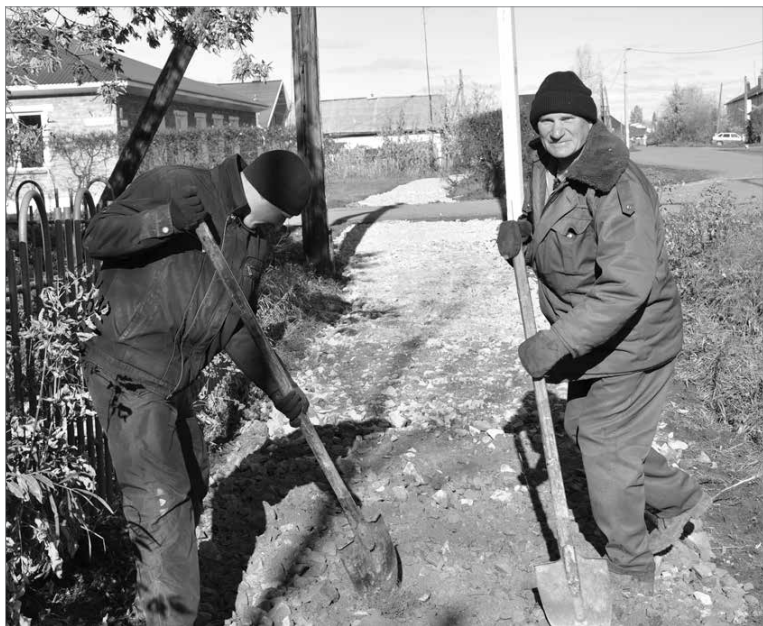
Когда материал готовился к печати, работы по прокладке тротуара для пешеходов были начаты Любинским ДРСУ.
