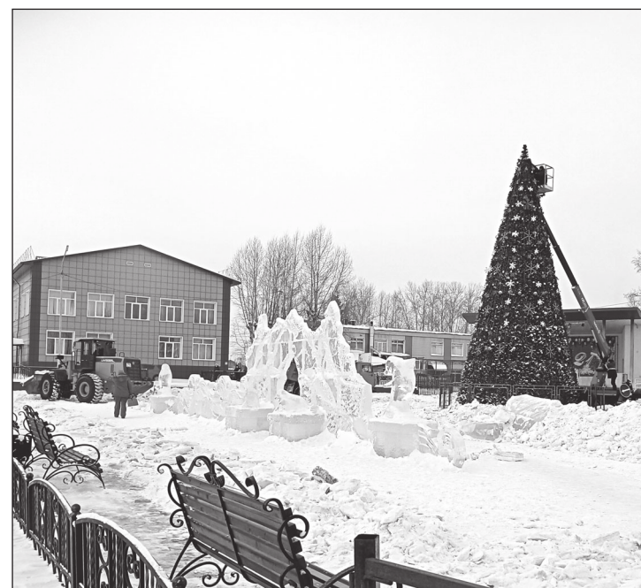
▲ 3 февраля 2021 года. Демонтаж новогодней площади
