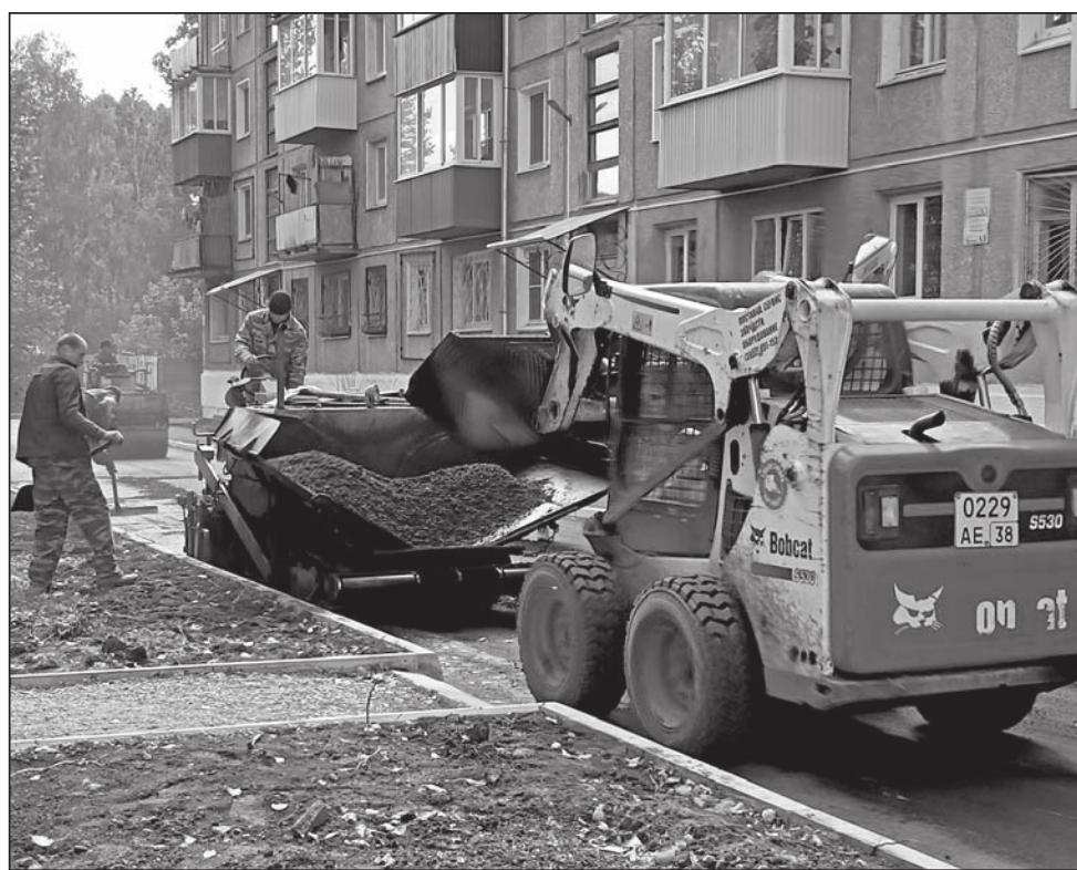
▲ Ведутся ремонтные работы во дворе дома № 6 в м-не Ангарском
