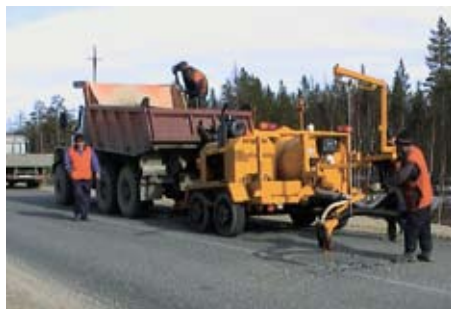
Массовый ремонт дорожного покрытия
