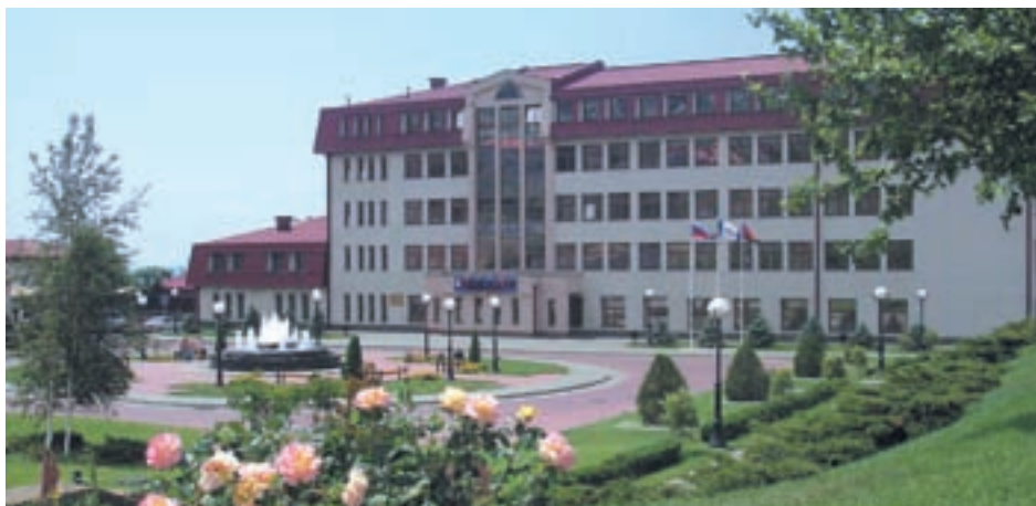
Здание аппарата управления ОАО «Черномортранснефть»
