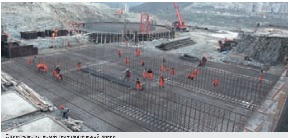
Строительство новой технологической линии
