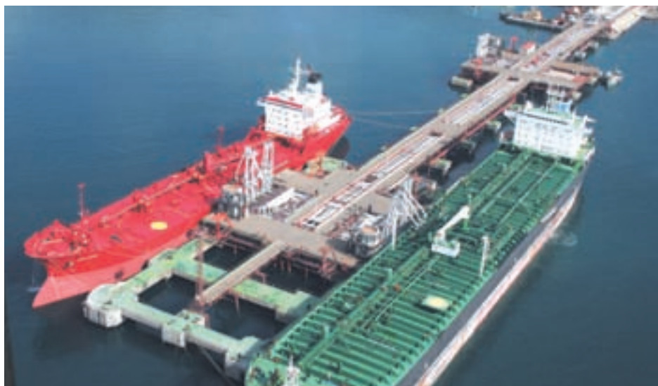
Нефтеналивные причалы (вид с высоты)
