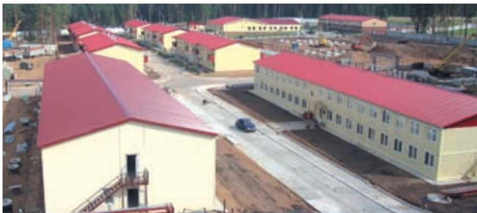
Работы по изготовлению каркасных конструкций ведутся круглогодично, в любых погодных условиях
