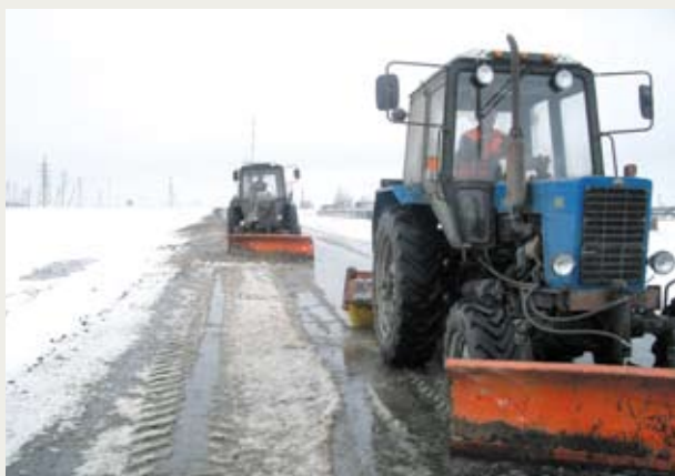
Уборка снега после противогололедной обработки покрытия
