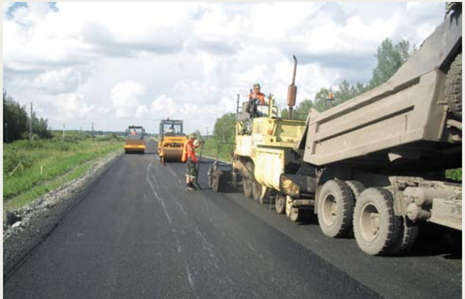
Устройство асфальтового покрытия при выполнении работ по капитальному ремонту автодороги Куйбышев—Северное в 2007—2008 годы
