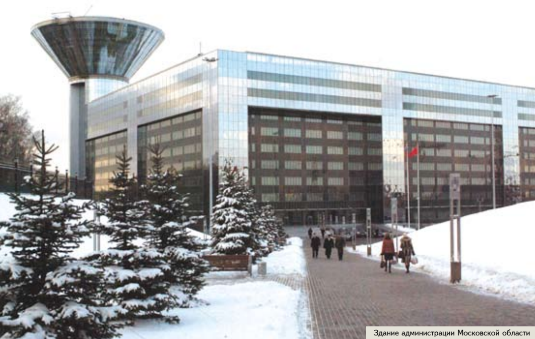
Здание администрации Московской области
