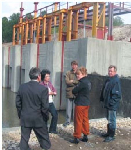
Проверка рабочей комиссией под руководством главы департамента экологии и природопользования Кировской области Аллы Албеговой (в центре) качества выполнения работ на объекте
