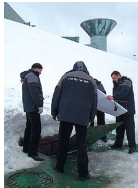
Регламентные работы на объекте Дом правительства Московской области
