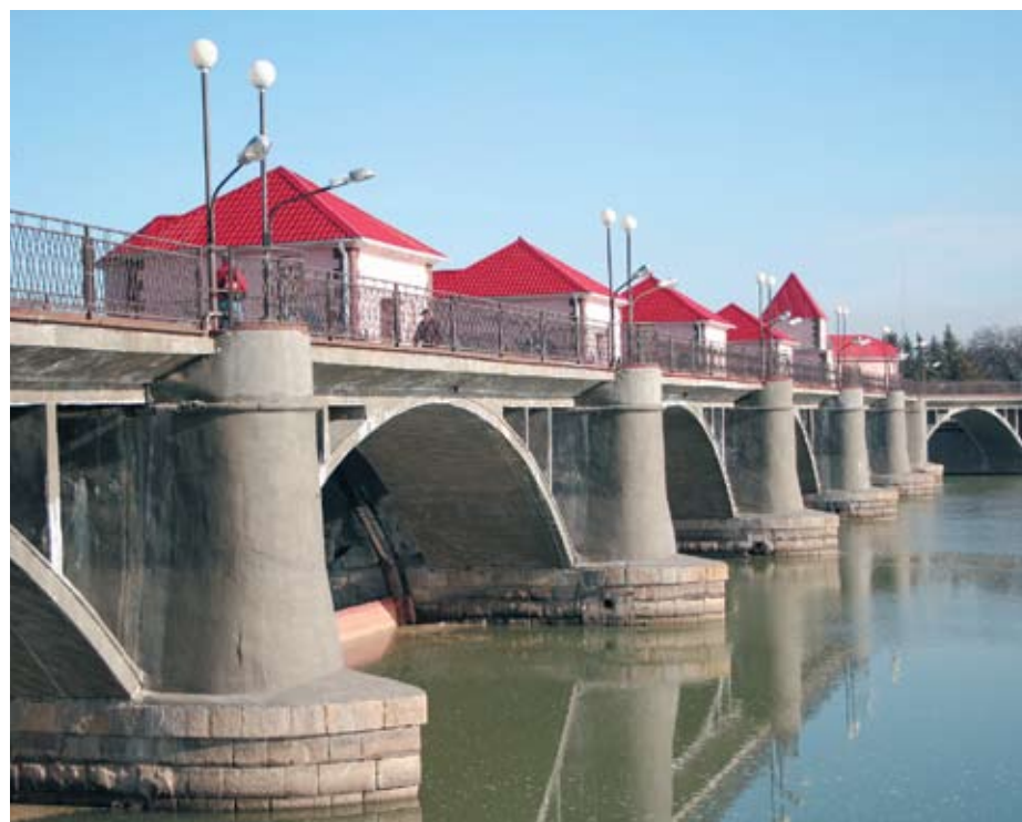
Плотина гидроузла Невинномысского канала на реке Кубань после реконструкции
