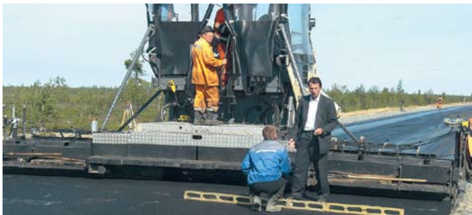
Устройство покрытия из асфальтобетона
