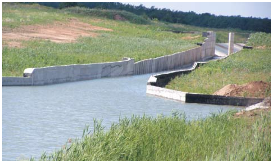
Построенный быстроток на четвертой очереди Большого Ставропольского канала
