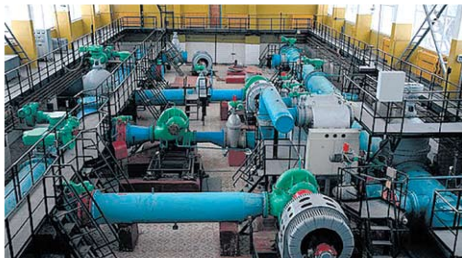
Производственный цикл насосной станции филиала ВСВ ГУП МО «КС МО»
