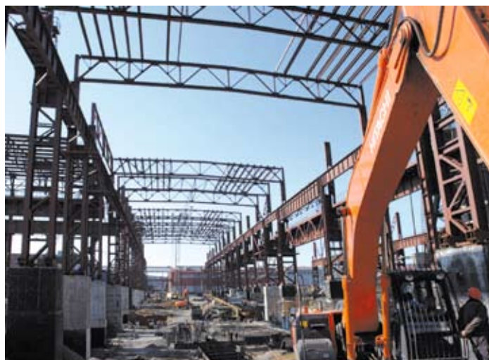
Строительно-монтажные работы на «стане-5000»
