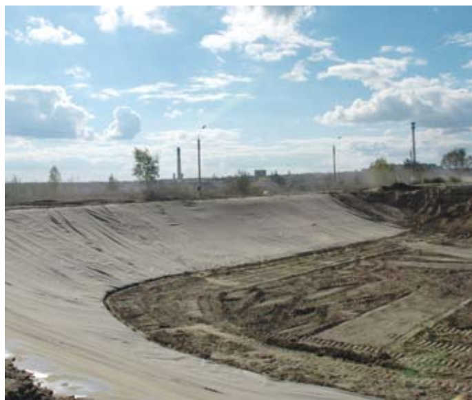
Площадки депонирования осадка с геомембранным водонепроницаемым покрытием
