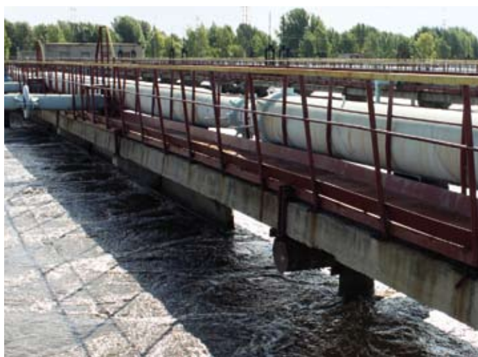
Реконструкция аэротенка №10 (100-процентная замена системы аэрации: 5400 п.м. трубопроводов, 3700 аэраторов нового типа; усиление стен методом торкретирования – 2900 кв. м; устройство коррозионно-стойкой системы ограждения (металл с полимерным покрытием)
