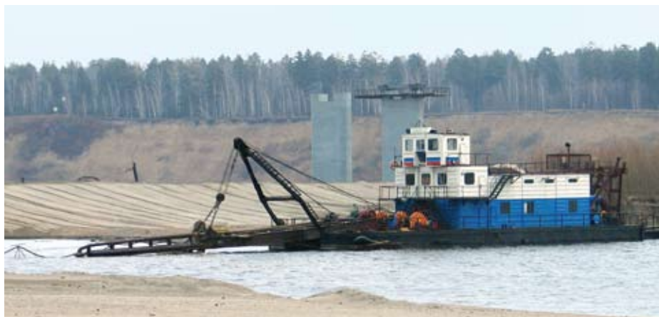
Дорожно-строительные земляные работы гидромеханизированным способом на строительстве автомобильной дороги Омск — Новосибирск
