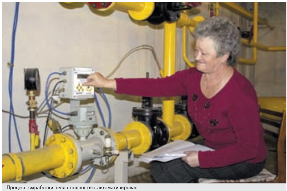
Процесс выработки тепла полностью автоматизирован
