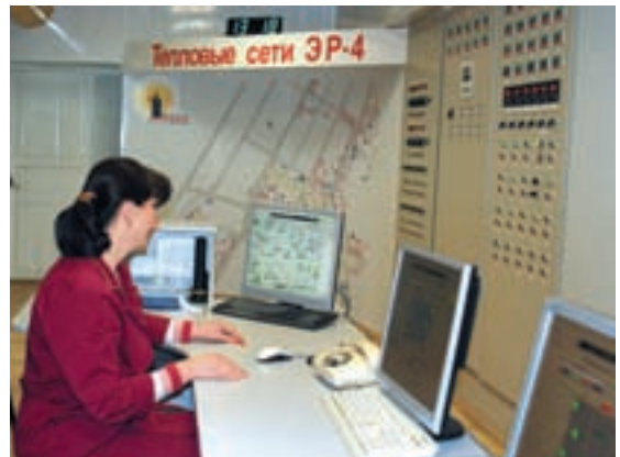
Автоматизированное рабочее место оператора котельной после реконструкции
