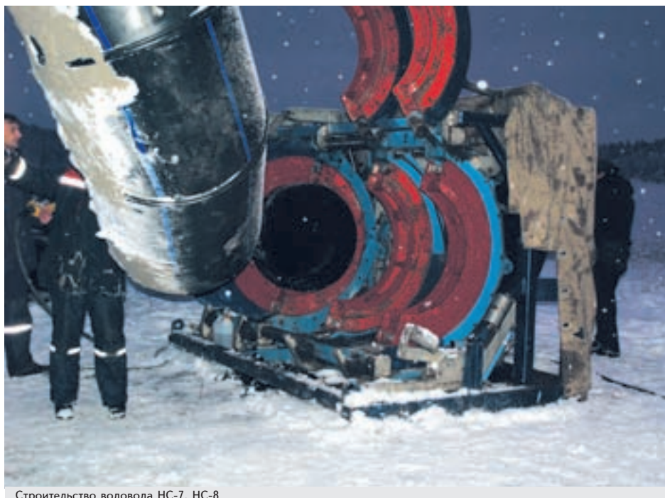
Строительство водовода НС-7, НС-8
