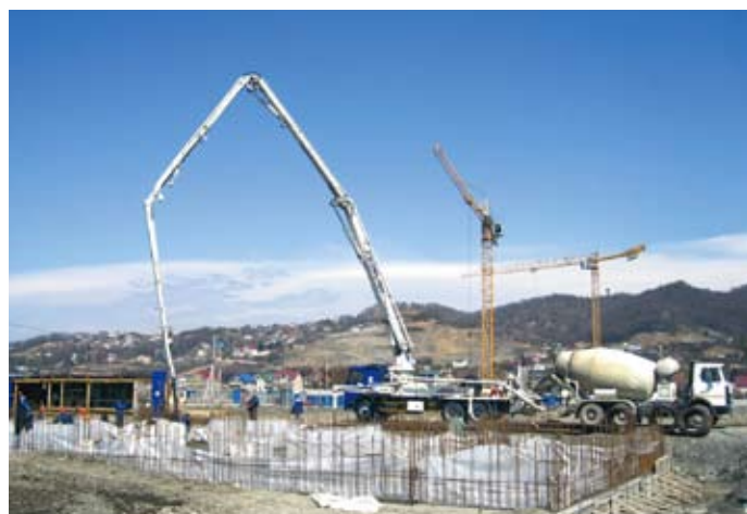
Строительство 5-этажного корпуса гостиницы в Олимпийском Парке Сочи. 30 марта 2012 г.
