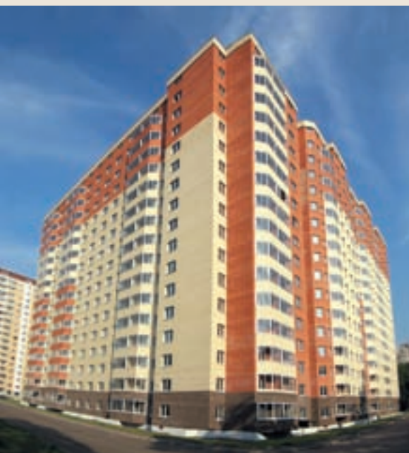
Монолитно-кирпичный жилой дом «Вишневый сад» (ул. Чехова, 13)
