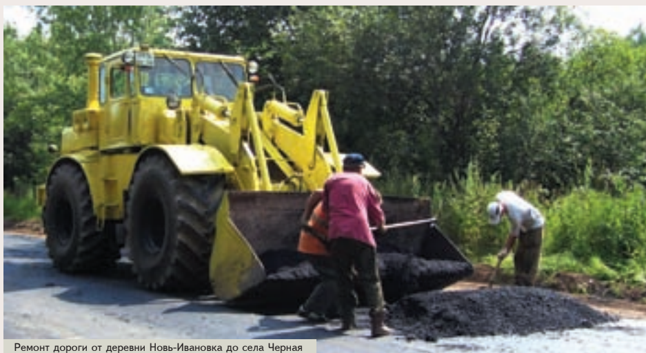
Ремонт дороги от деревни Новь-Ивановка до села Черная
