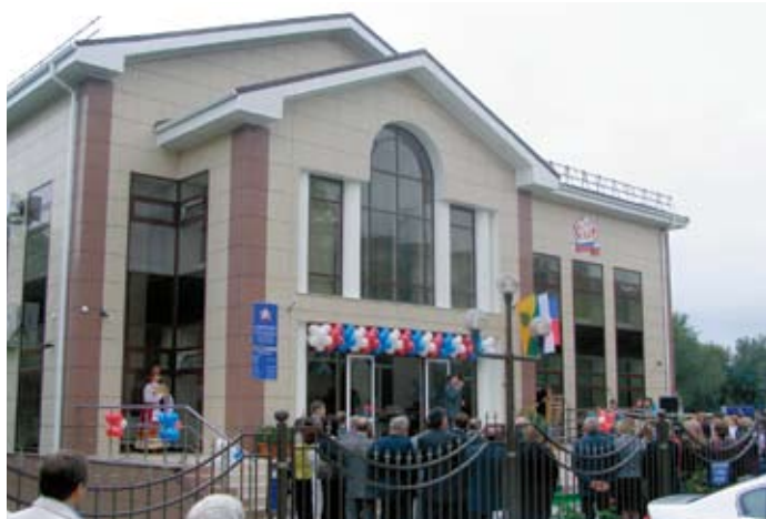
Строительство административного здания государственного учреждения управления Пенсионного фонда России в Буденновске
