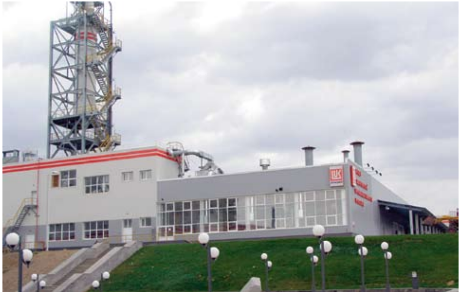
Строительство комплекса по производству полипропилена для ООО «Ставролен» в Буденновске
