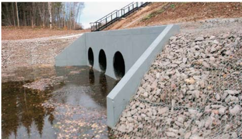
Капитальный ремонт водопропускной трубы на км 690+115 автомобильной дороги М-8 «Холмогоры».
