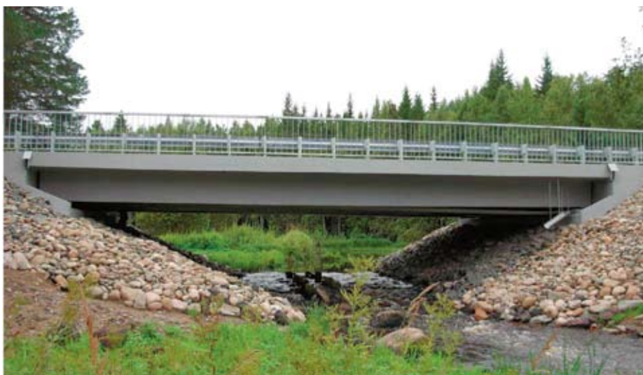
Ремонт моста через реку Маньга на км 456+857 на автомобильной дороге от Санкт-Петербурга через Приозерск, Сортавалу до Петрозаводска
