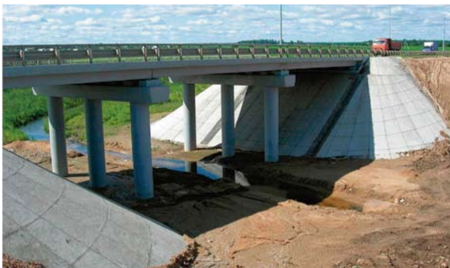
Строительство моста через реку Шолда-2 на автомобильной дороге А-114 Вологда — Новая Ладога на участке км 7+578 – 14+578
