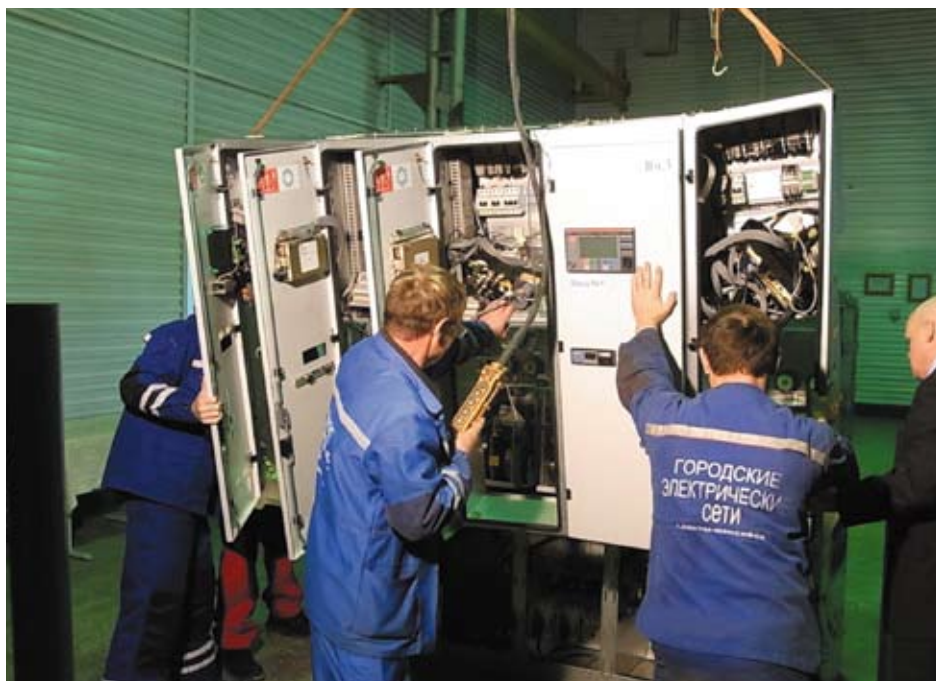
Сборка оборудования АBB-10 кВ электромонтерами предприятия
