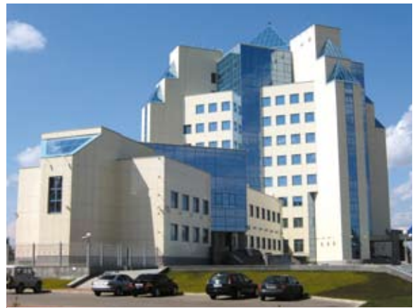
Здание ООО «Газпром трансгаз Югорск»
