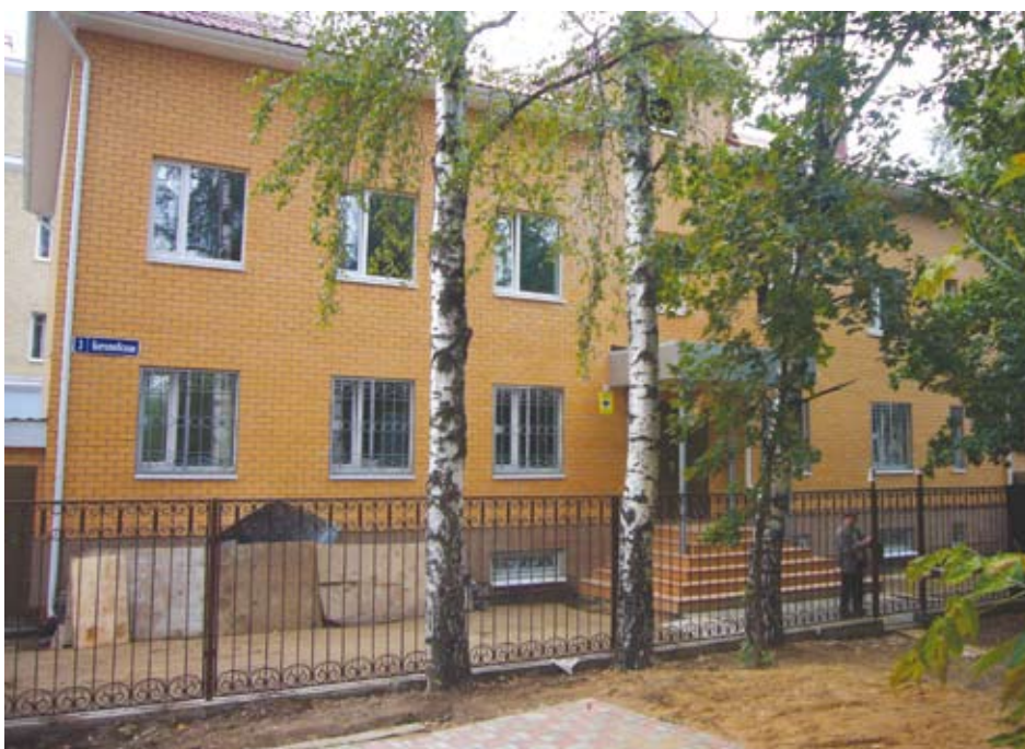
Новый офис компании ООО «Энергосервис»
