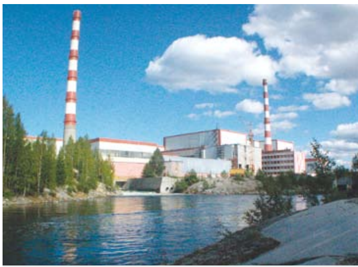
Мурманская область. Кольская АЭС. Сбросной канал
